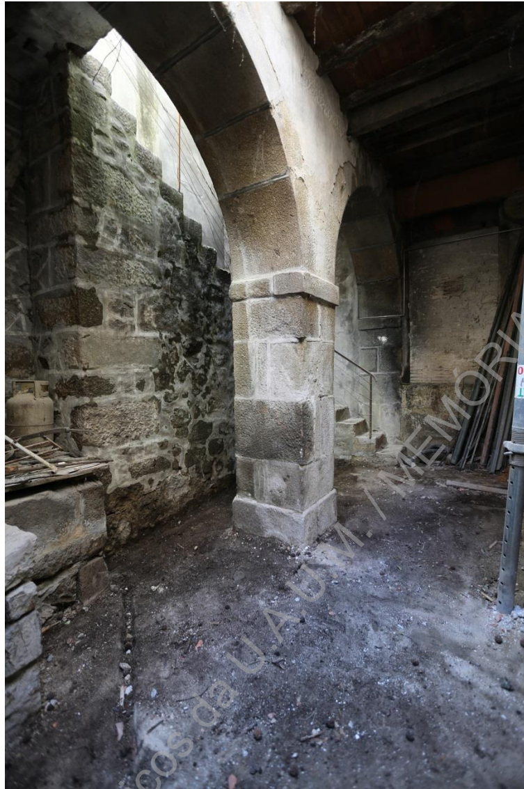
Foto 16: (UAUM-IMG_6034) Vista dos arcos (UE011), das escadas (UE020) de acesso ao piso 0 (arcos) e parede sul (UE022) NO-SE.
