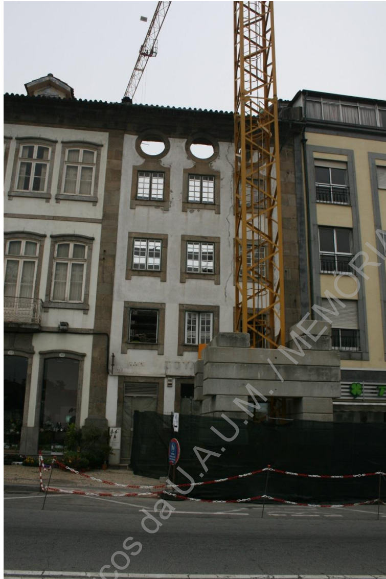
Foto 1: (UAUM-IMG_4618) Aspecto da fachada principal.
