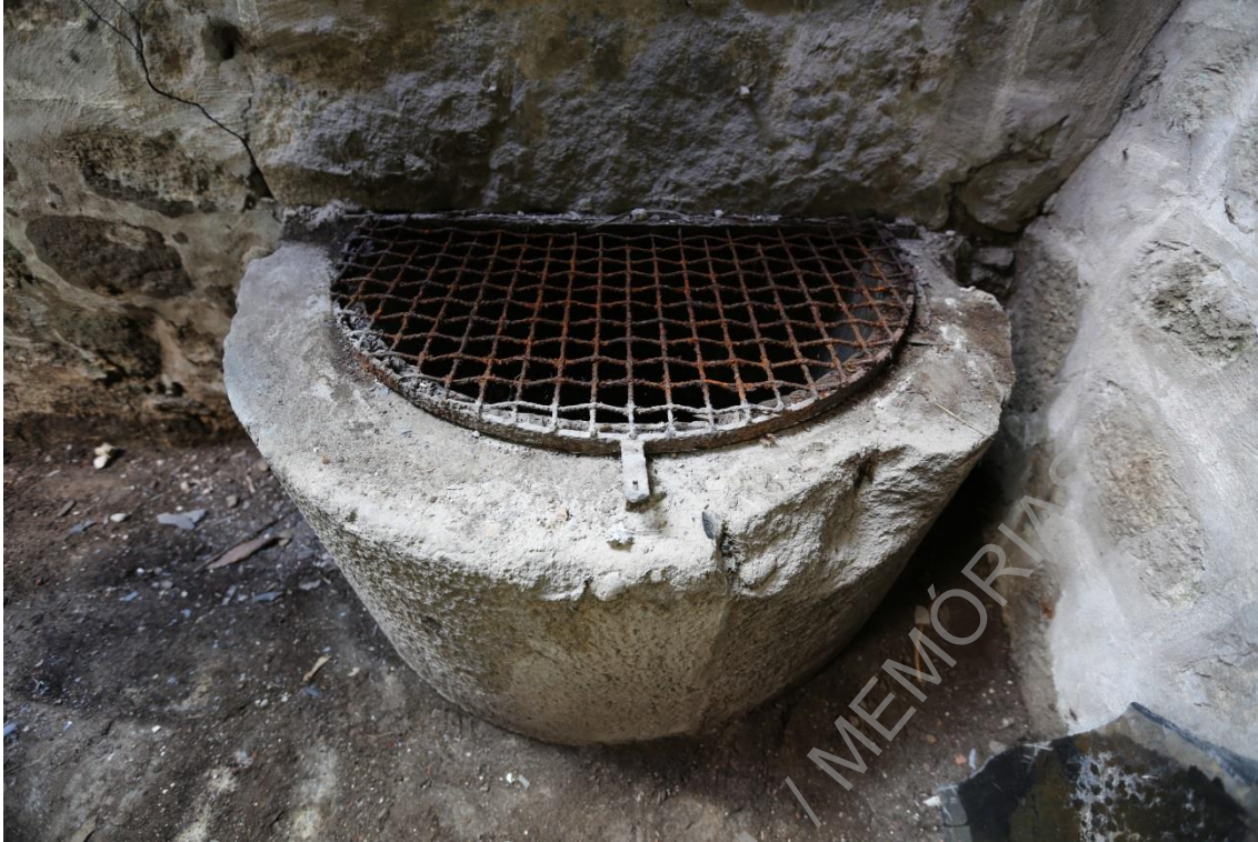
Foto 18: (UAUM-IMG_6081) Pormenor do poço (UE010).
