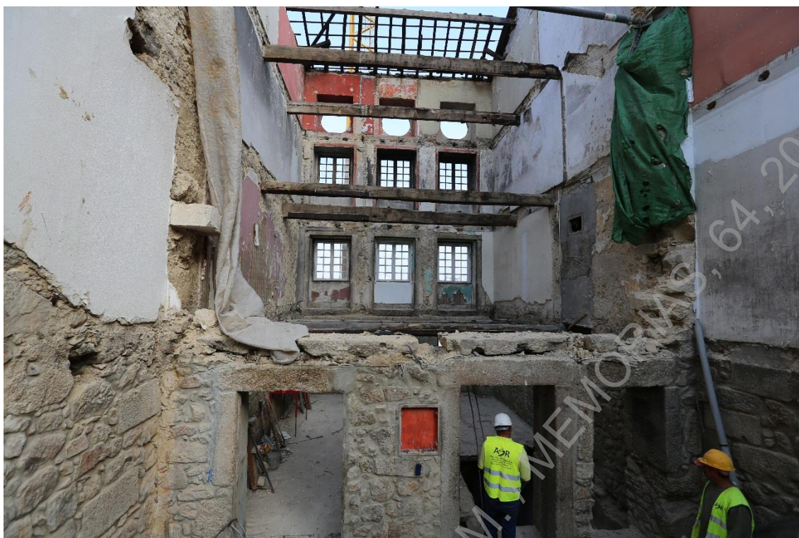
Foto 3: (UAUM- Z45A5946) Perspetiva geral dos trabalhos de demolição S-N.
