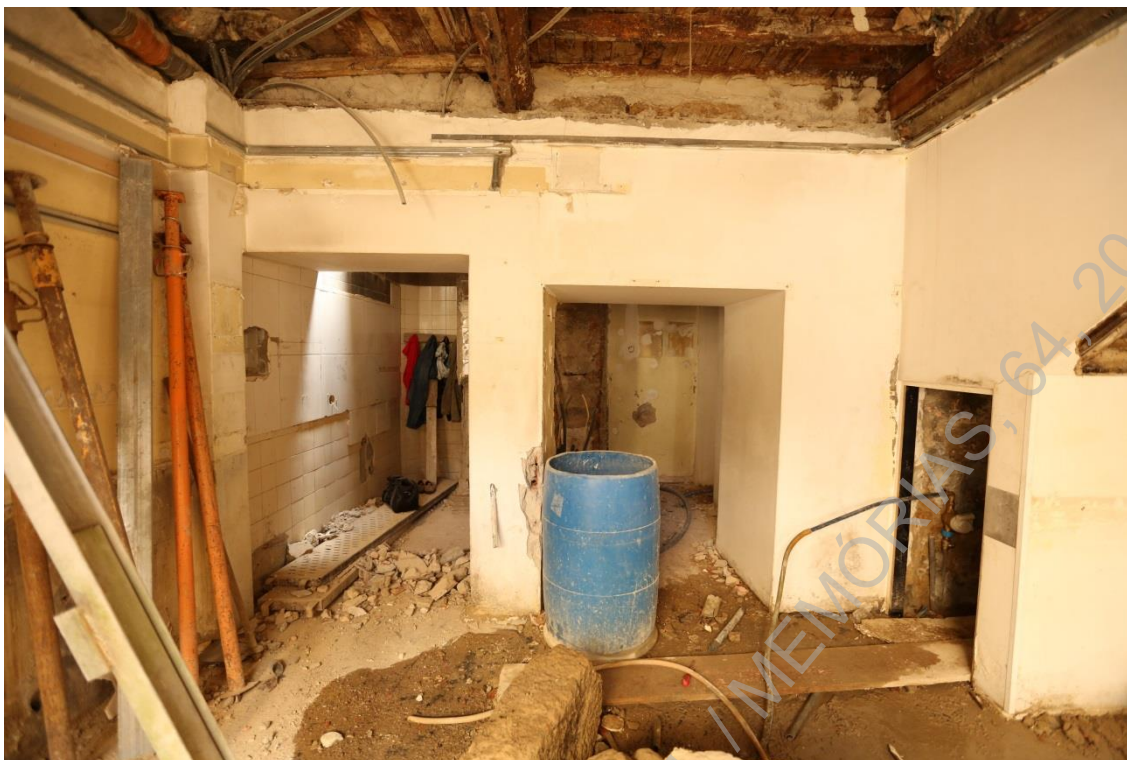
Foto 27: (UAUM-IMG_6157) Parede interior do piso 0 (UE012,013) S-N.
