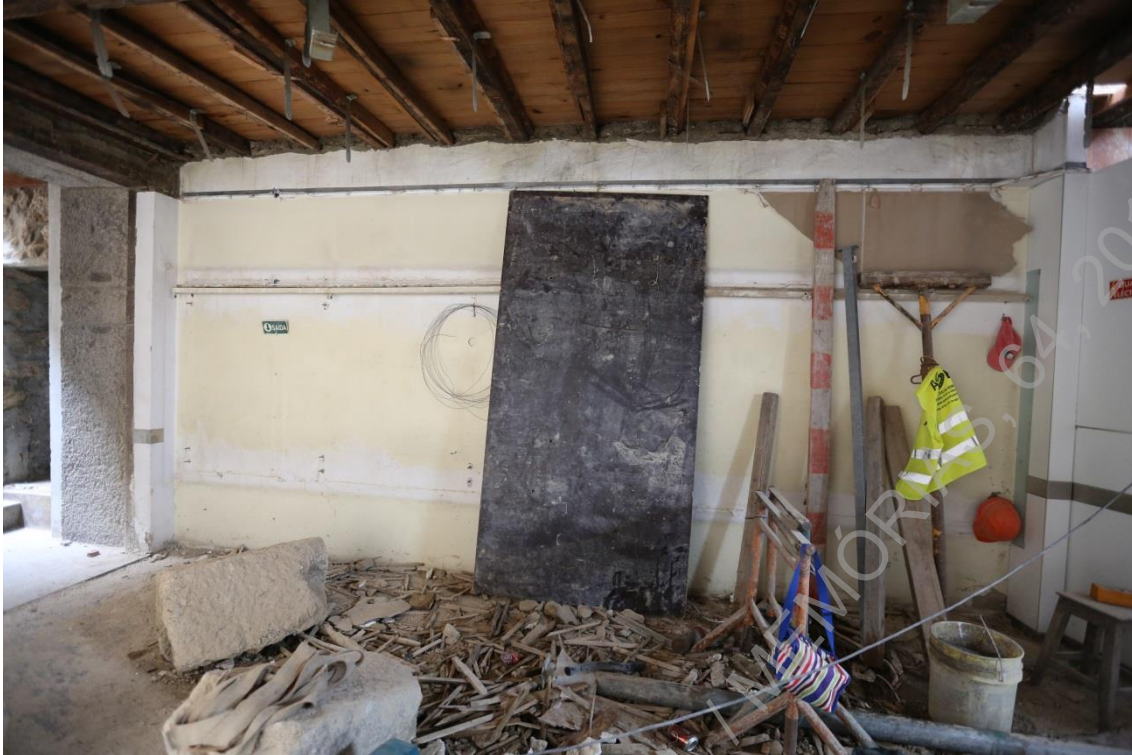
Foto 25: (UAUM-IMG_5941) Parede oeste do piso 0 (UE005) O-E.
