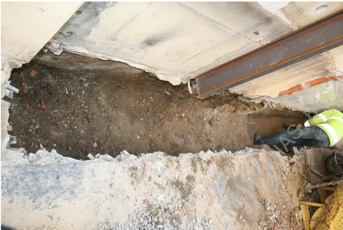
Foto 45: (UAUM-IMG_6134) Trabalhos de escavação da sondagem 1.
