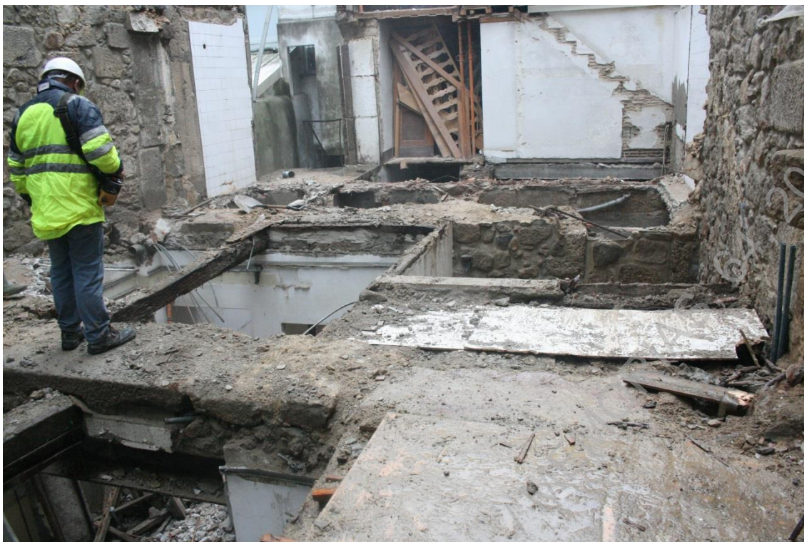
Foto 33: (UAUM-IMG_4788) Demolição do chão do piso 1.
