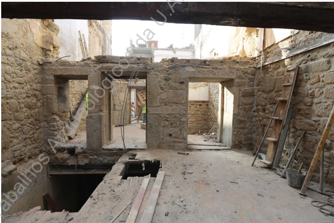
Foto 6: (UAUM-IMG_5961) Parede interior do piso 1 (UE002) N-S.
