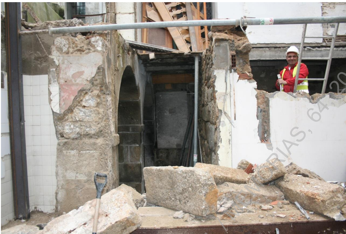
Foto 39: (UAUM-IMG_6033) Desmantelamento das paredes (UE007,UE008) do piso 0 (arcos).
