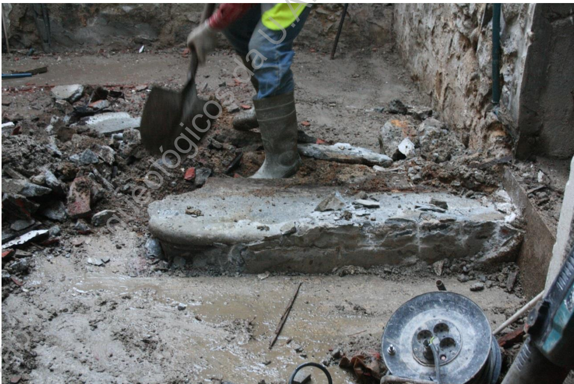
Foto 36: (UAUM-IMG_4814) Degrau original das antigas escadas (UE022).
