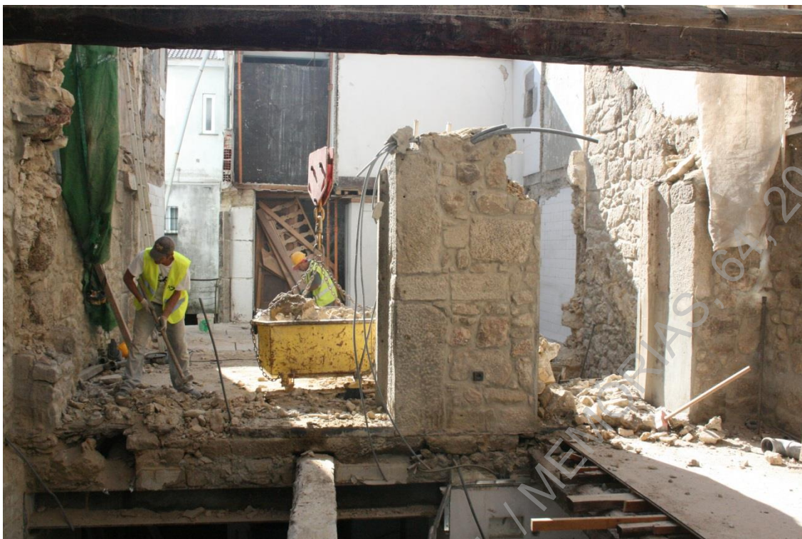
Foto 31: (UAUM-IMG_4728) Desmantelamento da parede intermédia do piso 1 (UE002).
