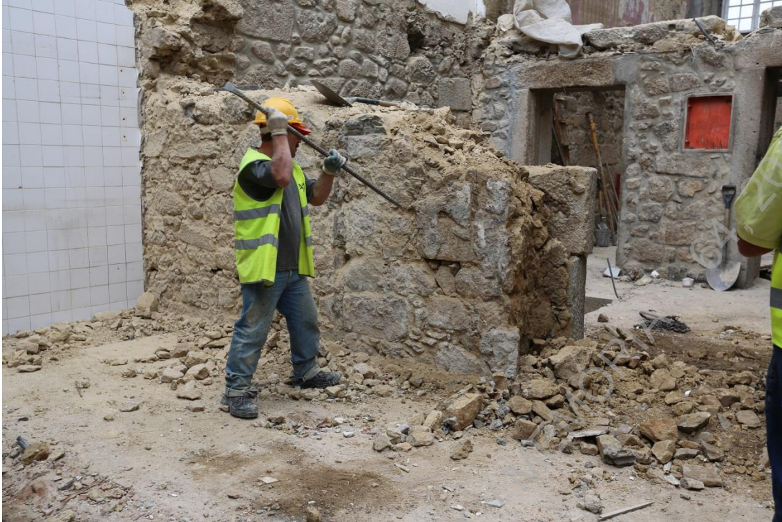
Foto 29: (UAUM-IMG_6180) Desmantelamento da parede intermédia no piso 1 (UE001).
