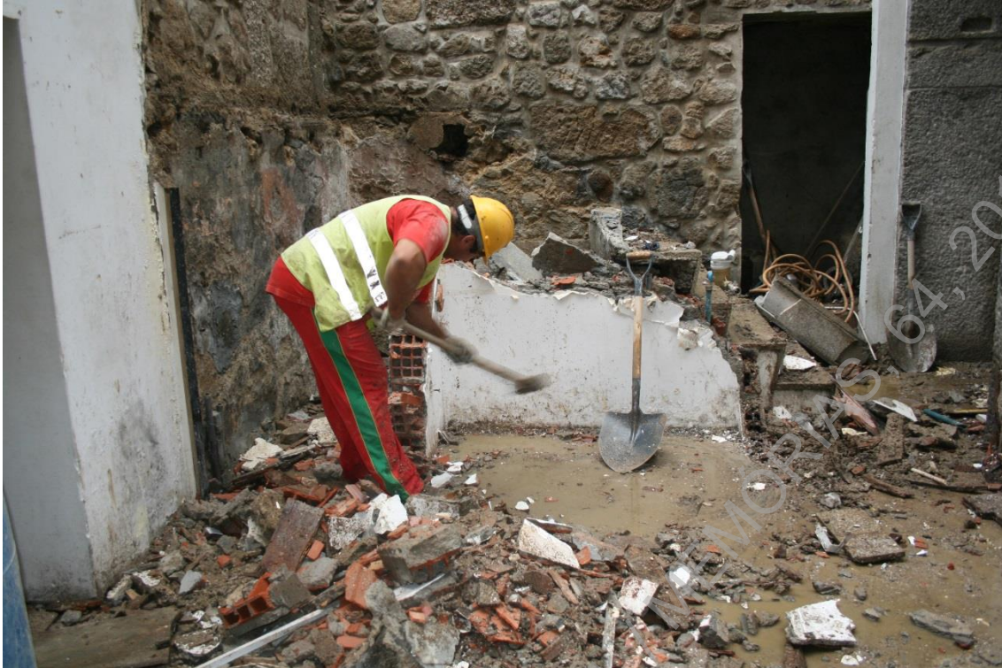
Foto 35: (UAUM-IMG_4807) Demolição do pilar (UE13) do piso 0.
