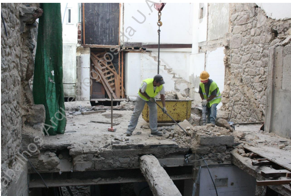
Foto 32: (UAUM-IMG_4749) Demolição da parede intermédia no piso 1 (UE002).
