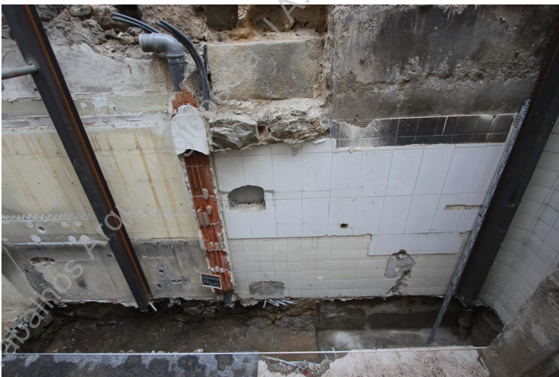
Foto 46: (UAUM-IMG_3296) Perfil este sondagem 1.
