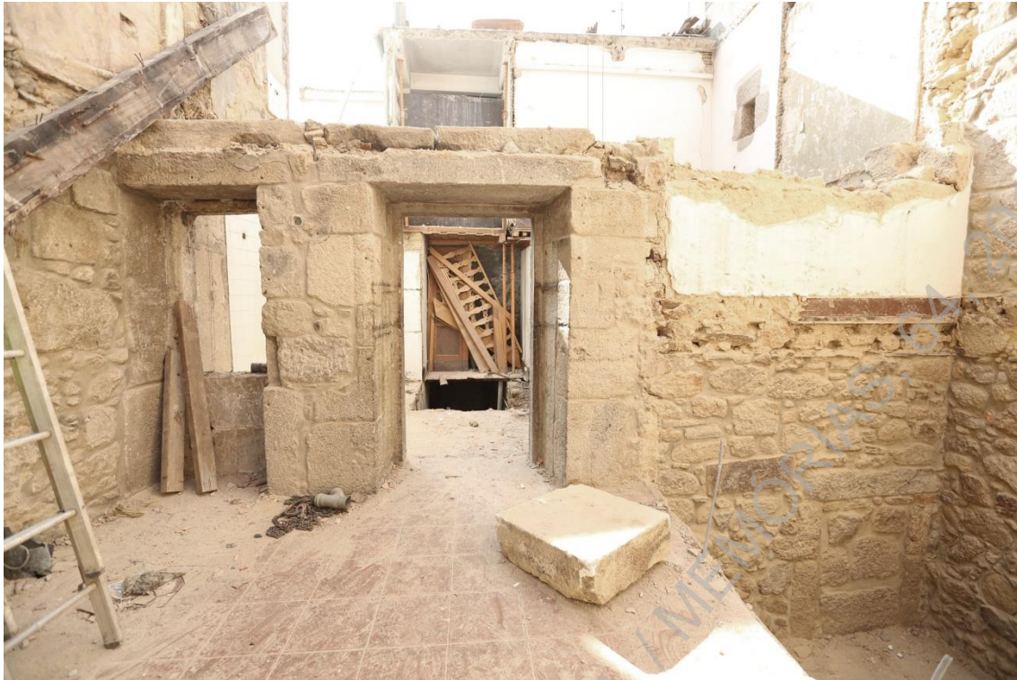
Foto 5: (UAUM-IMG_6017) Parede interior do piso 1 (UE001) N-S.
