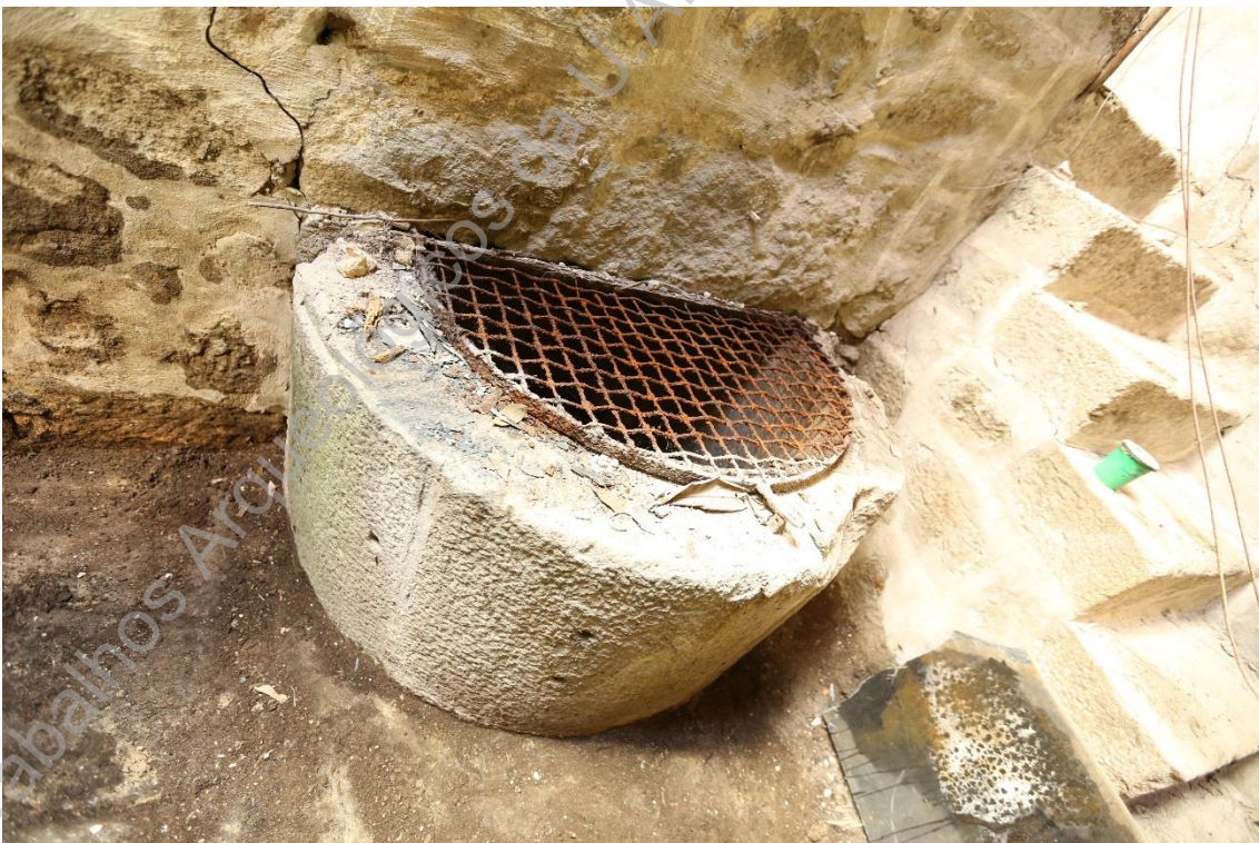
Foto 19: (UAUM-Z45A6077) Vista das paredes exteriores do poço (UE010).
