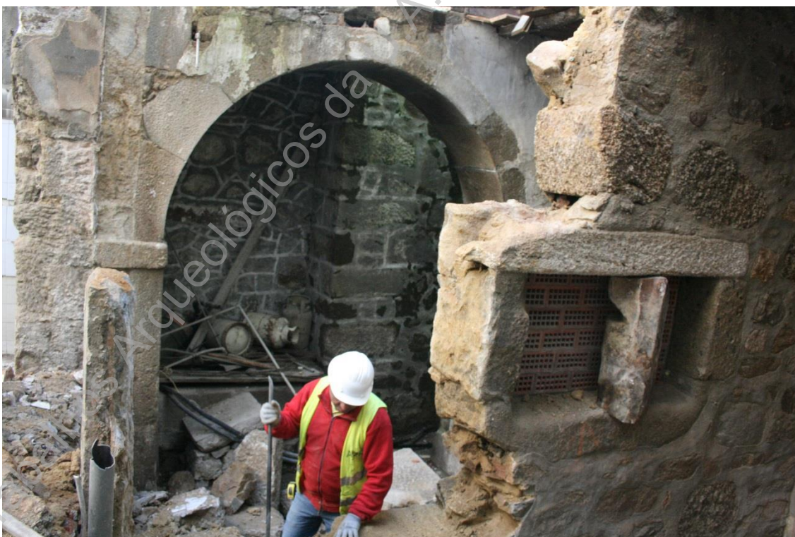
Foto 40: (UAUM-IMG_6055) Desmantelamento das paredes (UE007,UE008) do piso 0 (arcos).
