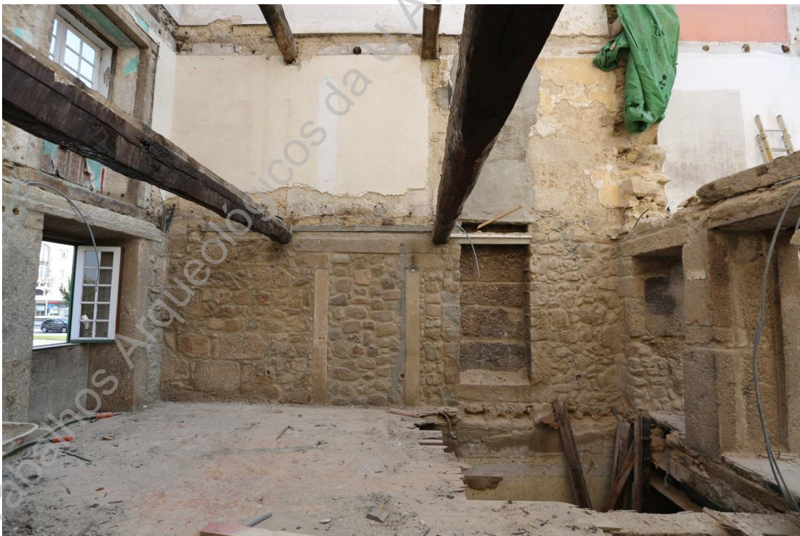
Foto 8: (UAUM-IMG_5987) Parede este do piso 1 (UE004) O-E.
