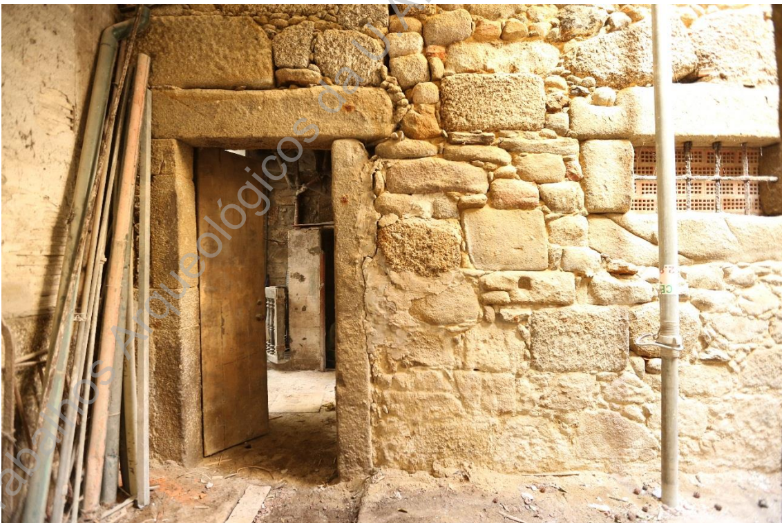
Foto 22: (UAUM-Z45A6089) Pormenor da abertura na parede oeste (UE008) do piso 0 E-O.
