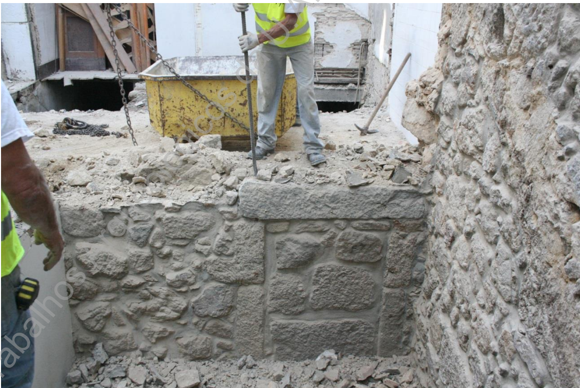
Foto 30: (UAUM-IMG_4701) Desmantelamento da parede intermédia no piso 1 (UE001).
