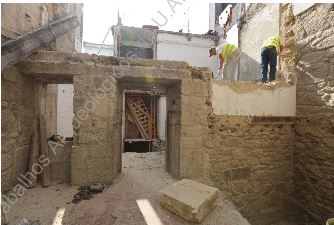
Foto 10: (UAUM- Z45A6113) Pormenor dos trabalhos de demolição no piso 1 (UE001) N-S.
