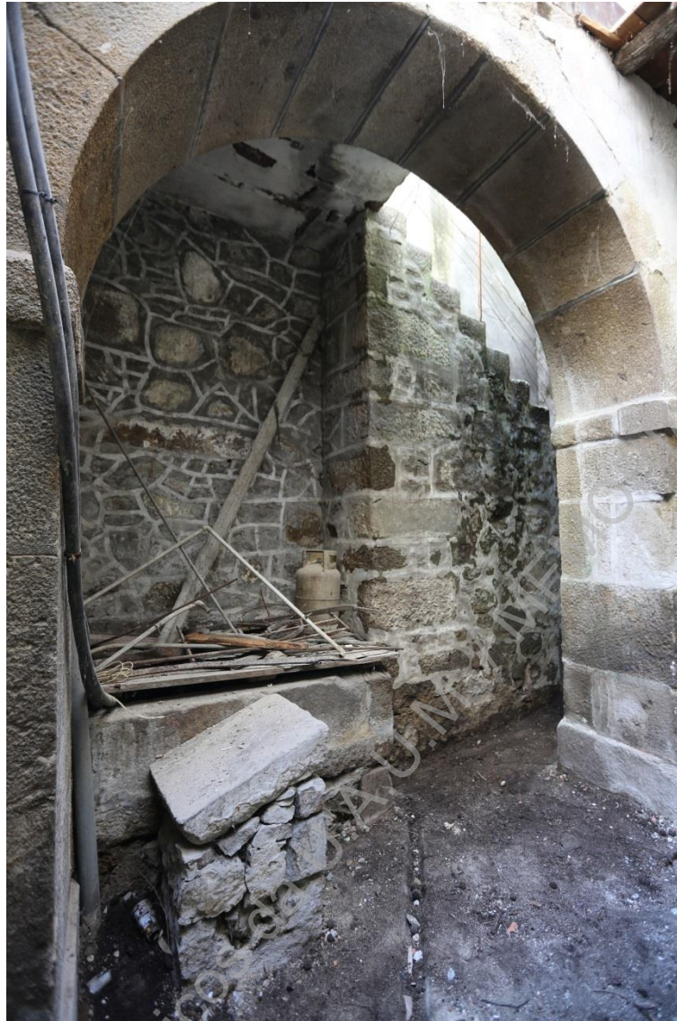
Foto 15: (UAUM-IMG_6051) Vista do arco (UE011), tanque (UE017) e parede este (UE005) do piso 0 O-E.
