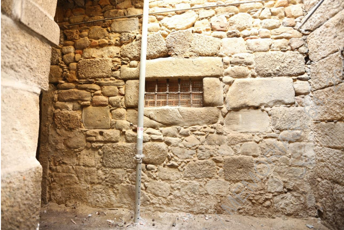
Foto 21: (UAUM-IMG_6088) Parede oeste (UE008) do piso 0 E-O.
