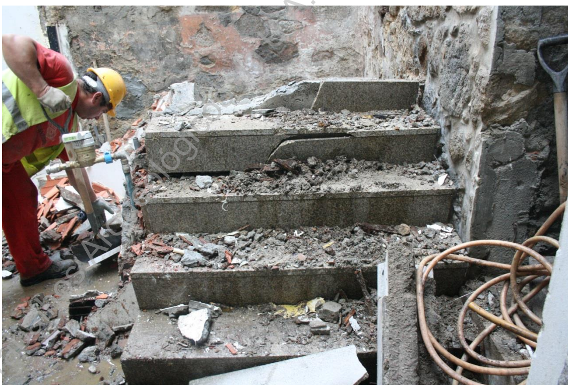
Foto 34: (UAUM-IMG_4795) Desmantelamento das escadas (UE021) de acesso ao piso 1.
