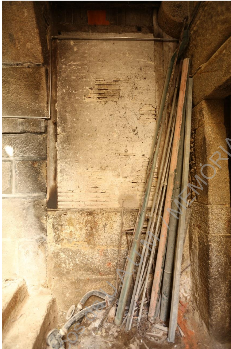
Foto 20: (UAUM-IMG_6076) Parede sul (UE009) do piso 0 N-S.
