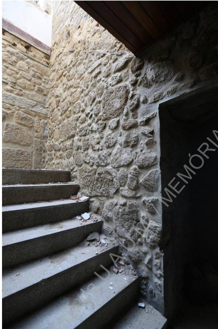
Foto 24: (UAUM-IMG_6137) Escadas (UE021) de acesso ao piso 1.
