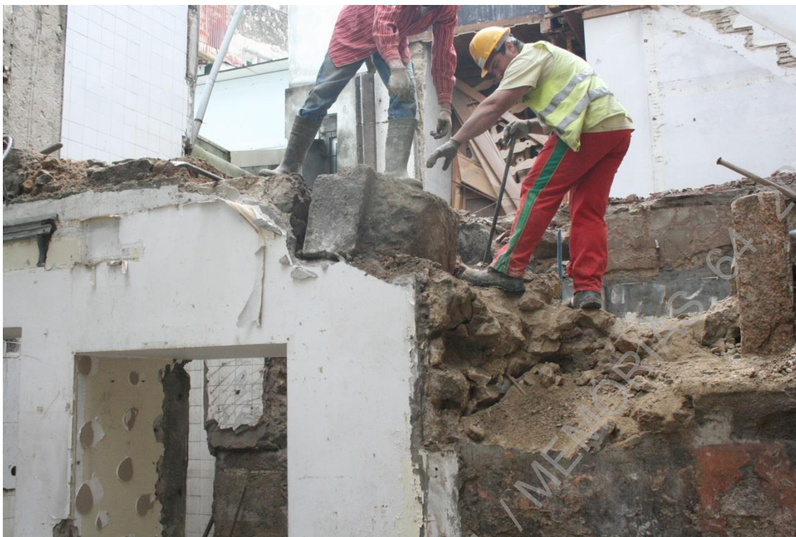
Foto 37: (UAUM-IMG_4824) Desmantelamento das paredes interiores do piso 0 (UE012,UE013 e UE016).
