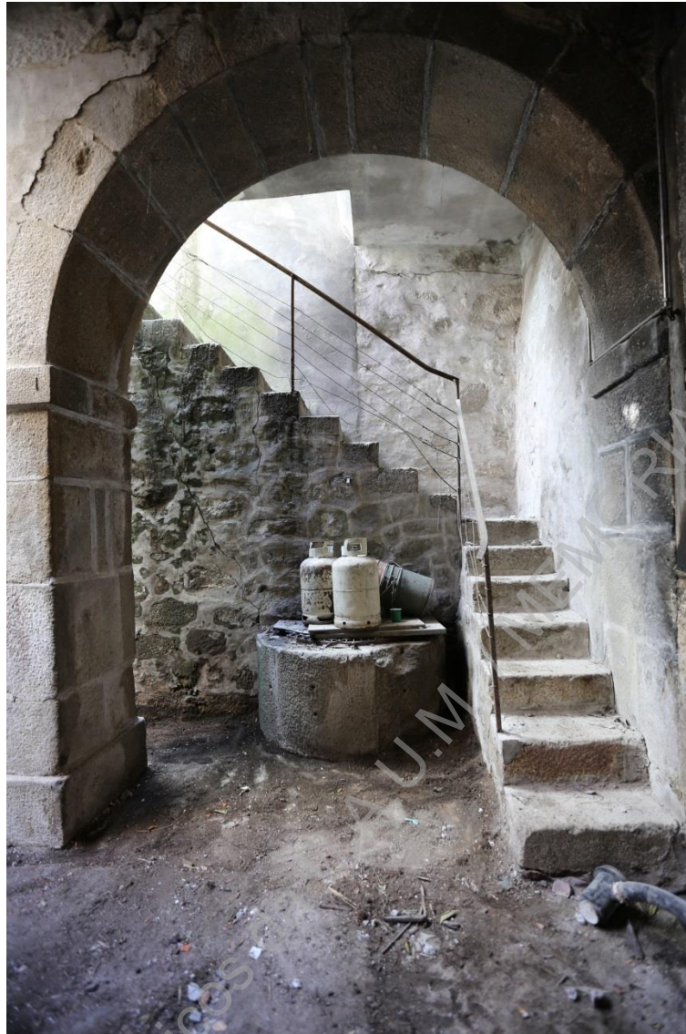
Foto 17: (UAUM-IMG_6034) Vista dos arcos (UE011), das escadas (UE020) de acesso ao piso 0 (arcos) e do poço (UE010) O-E.
