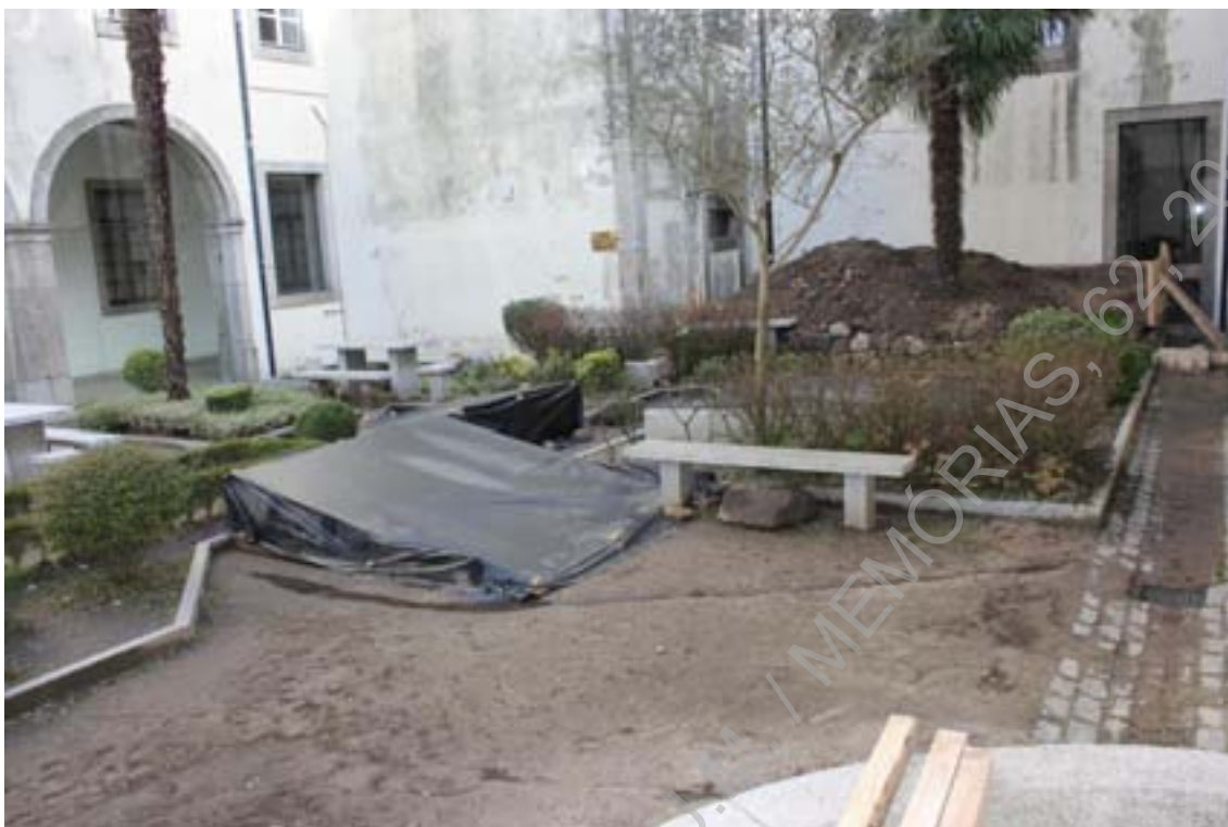
Foto 111 (IMG_8316) – Coberturas das sondagens 3, 5 e 7.
