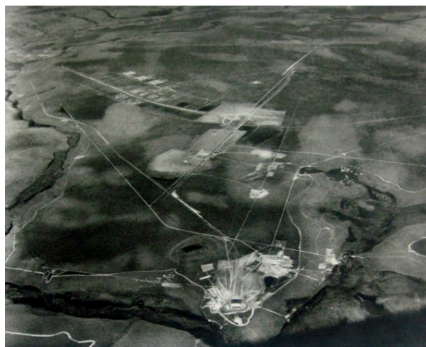
Figura 6. Brasília em construção, imagem aérea (fonte: “isto é | this is Brasília”, sd, p.11, ArPDF)
