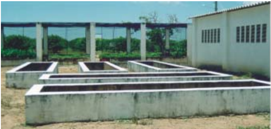
FIG. 2. Tanques de compostagem para formação de substrato no processo de produção de mudas de cajueiro.
