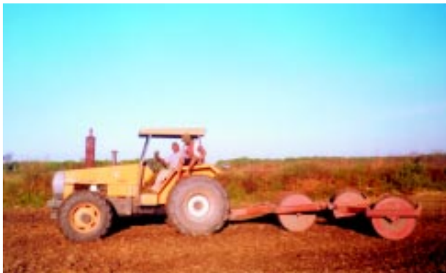
Fig. 3. Uso de compactadores de solo, após o seu preparo convencional, em várzea irrigada por subirrigação. Lagoa da Confusão-TO. 2003.
