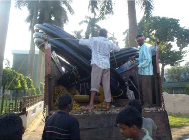
HDPE పైపులు కేజ్ ఫ్రెయిమ్ కేపన్ కోరుకు
