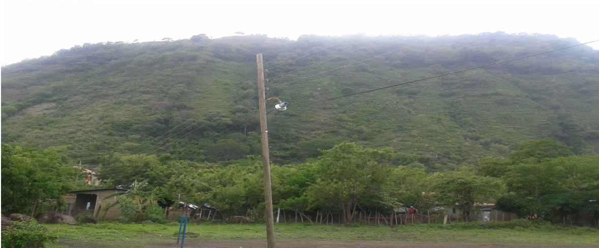
Cerros cercanos al centro escolar y cerca perimetral en mal estado parte oeste
