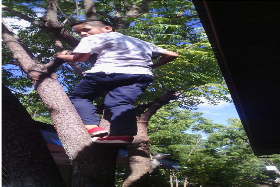
Estudiante trepando al techo por donde pasan los cables eléctricos
