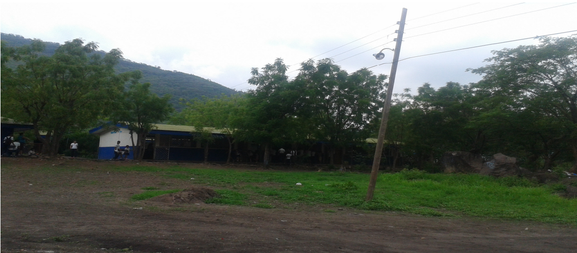
Poste de luz dentro del predio escolar en la zona de seguridad
