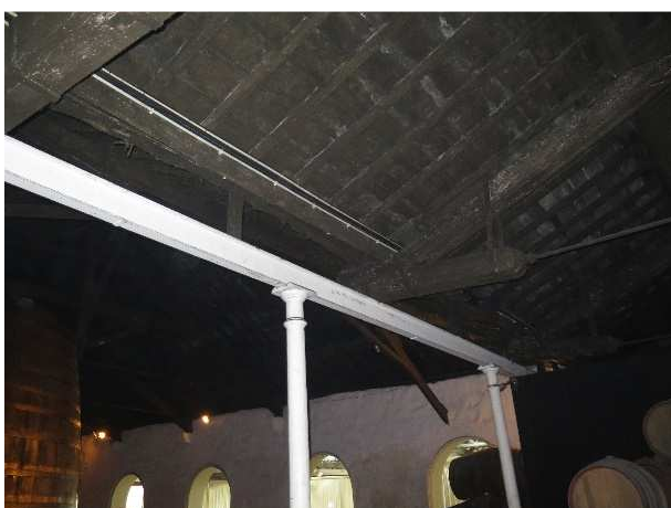
(a) Vista geral do pórtico metálico
