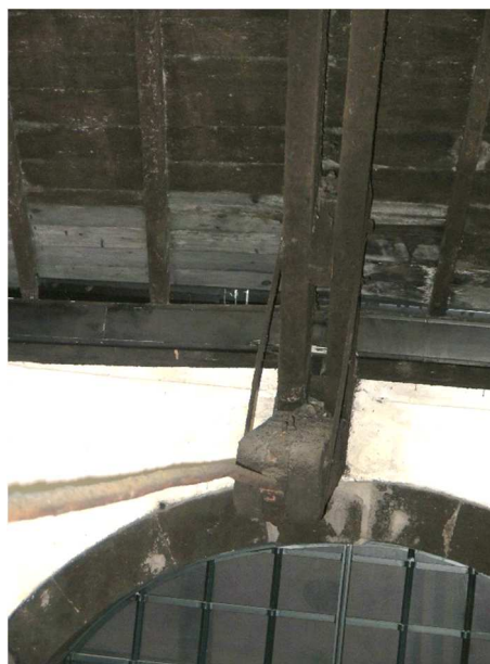
(b) Deformação/rotação do apoio e deformação do tirante na mesma asna.
