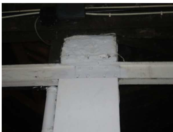
(b) Apoio na parede perpendicular a empena B
