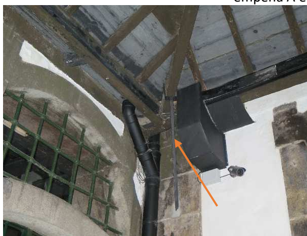
(c) Reforço metálico de apoio ao rincão do lado B
