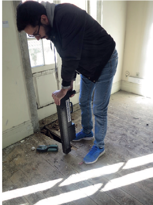
Figura 3.3 – Utilização do resistógrafo no âmbito de inspeção e diagnóstico de estruturas.
