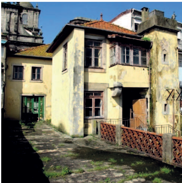
a) Edifício na Rua São Bento da Vitória, Porto.
