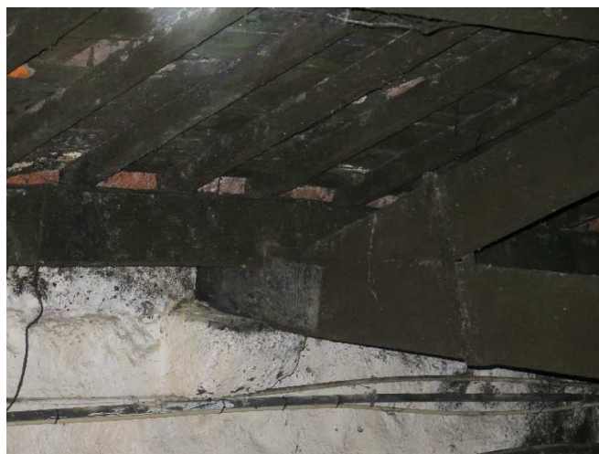
(b) Cachorro de pedra para apoio das asnas na parede
