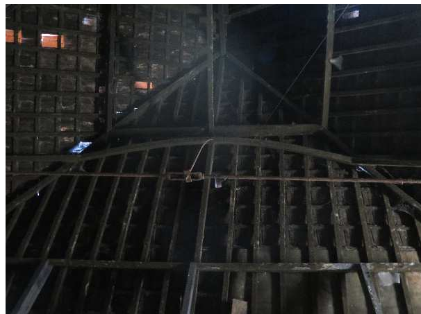
(b) Deformação da linha superior da asna tipo B
