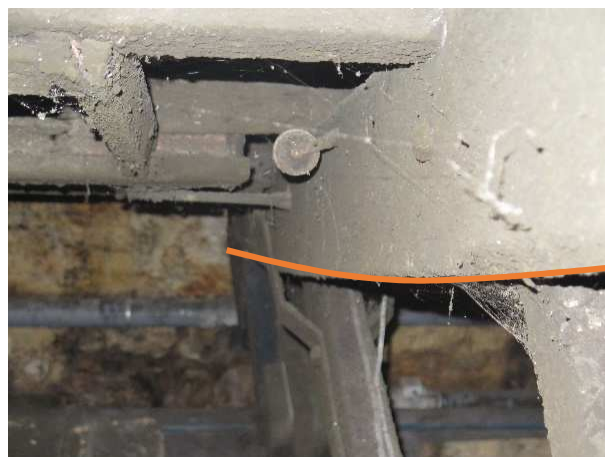
d) Deformação da perna da asna A11
