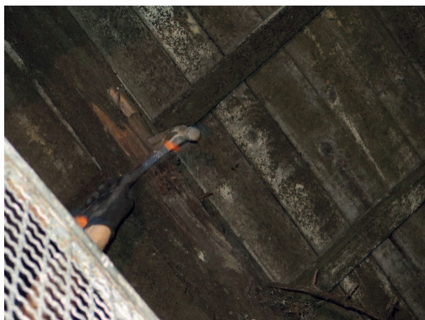
(a) Utilização de martelo
