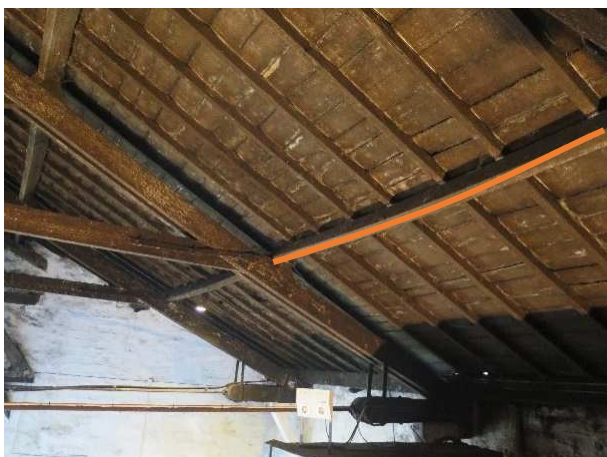
c) Deformação da madre entre asna A3 e A4
