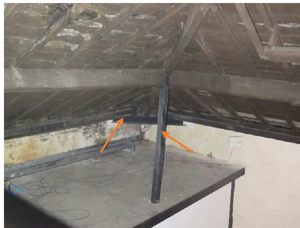
(b) Prumo de suporte do rincão no lado da empina A e perfil metálico
