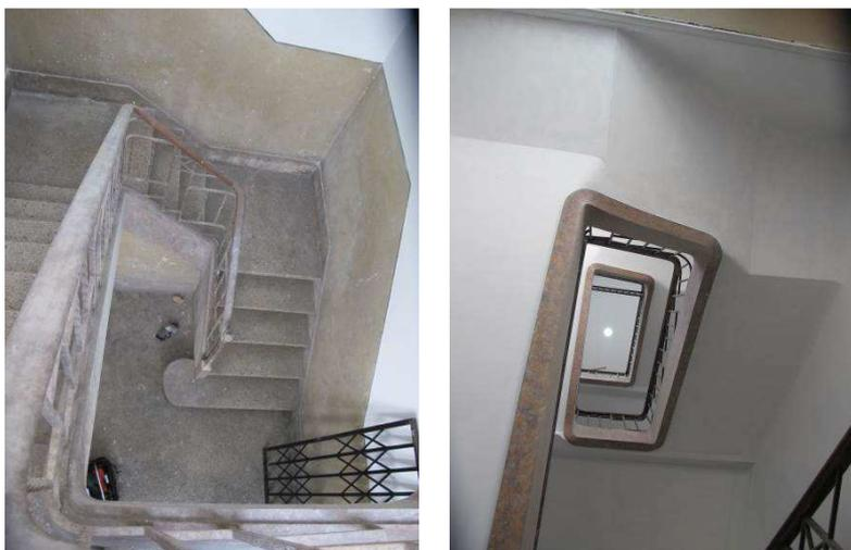
Figura 2.23 – Caixa de escadas em betão armado, (NCREP, 2016b).
