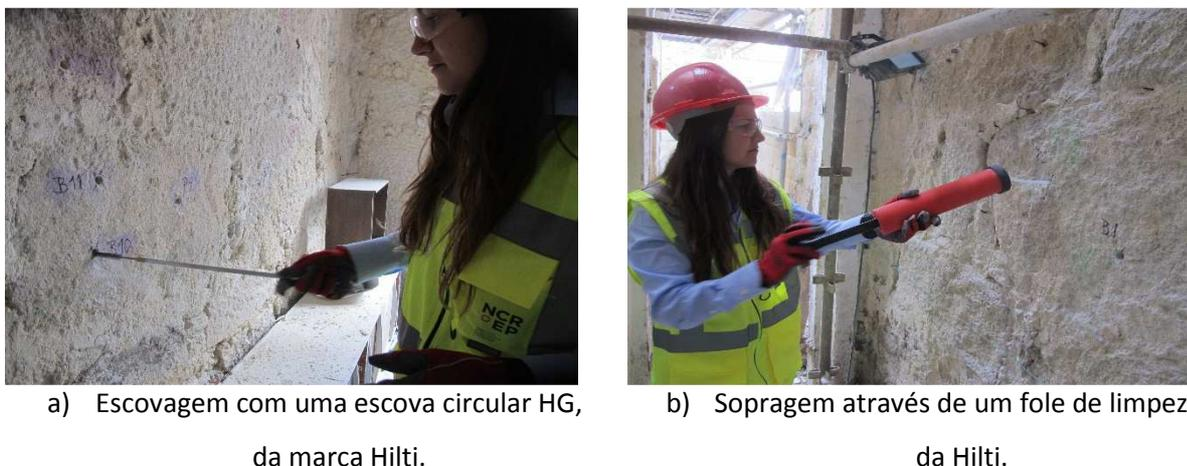
Figura 4.9 - Limpeza dos furos da parede de alvenaria.
