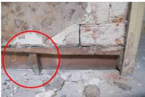
a) Configuração de parede paralela à fachada principal (prumo vertical a vermelho).
