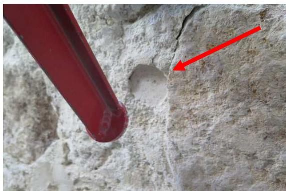
Figura 5.7 - Deformação da junta de argamassa, causada pelo tripé.
