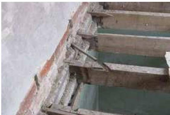
d) Apoio das vigas em lintel de betão armado.
