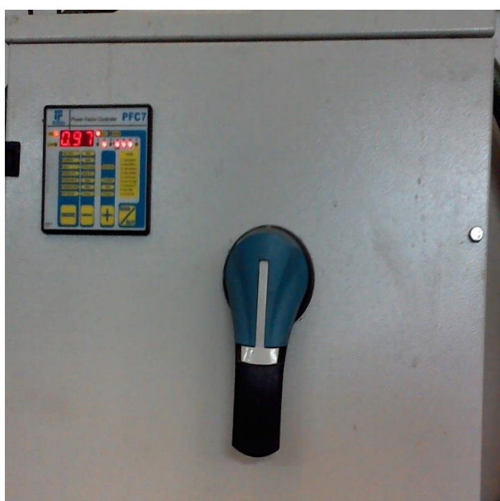
Figura 10 Bateria de Condensadores Instalada
