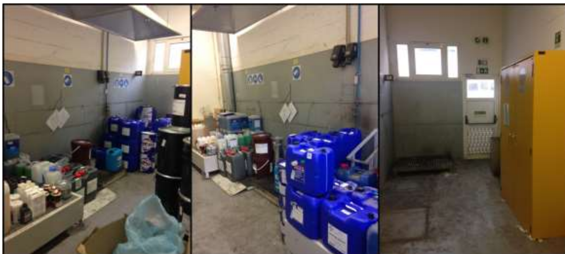
Figura 119 Sala de químicos antes da otimização
