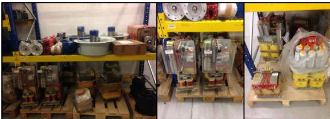
Figura 106 Arrumação de transformadores
