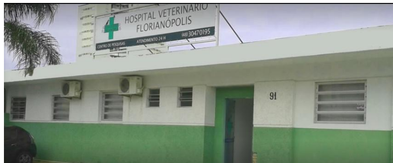
Figura 1 - Fachada do Hospital Veterinário Florianópolis
