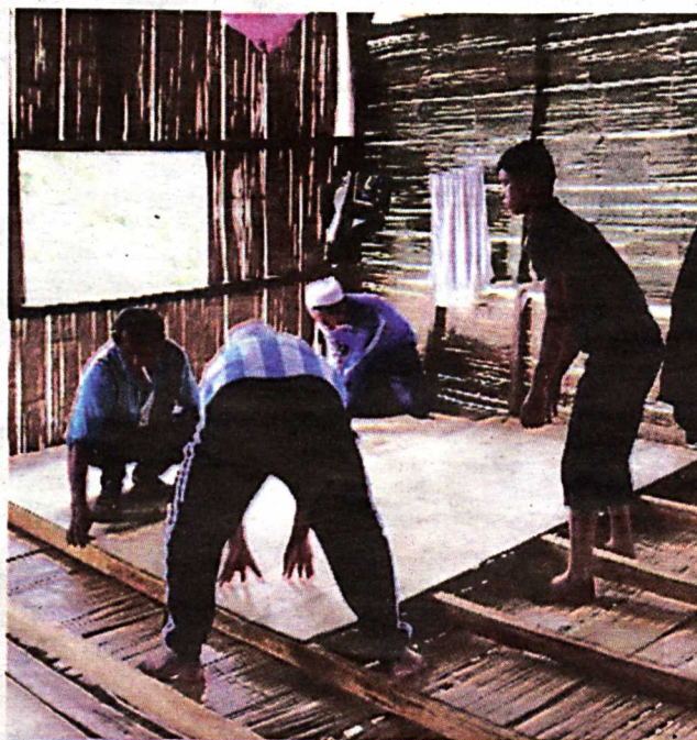
SEBAHAGIAN sukarelawan sibuk memasang lantai surau daripada papan lapis bagi menggantikan lantai lama daripada batang buluh.
