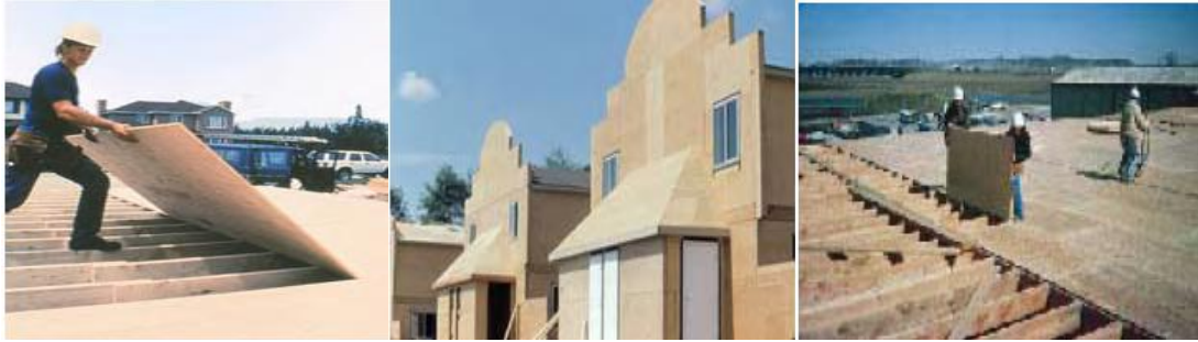
Şekil 2. Kontrplağın Zemin, Duvar ve Çatılarda Kullanımı
