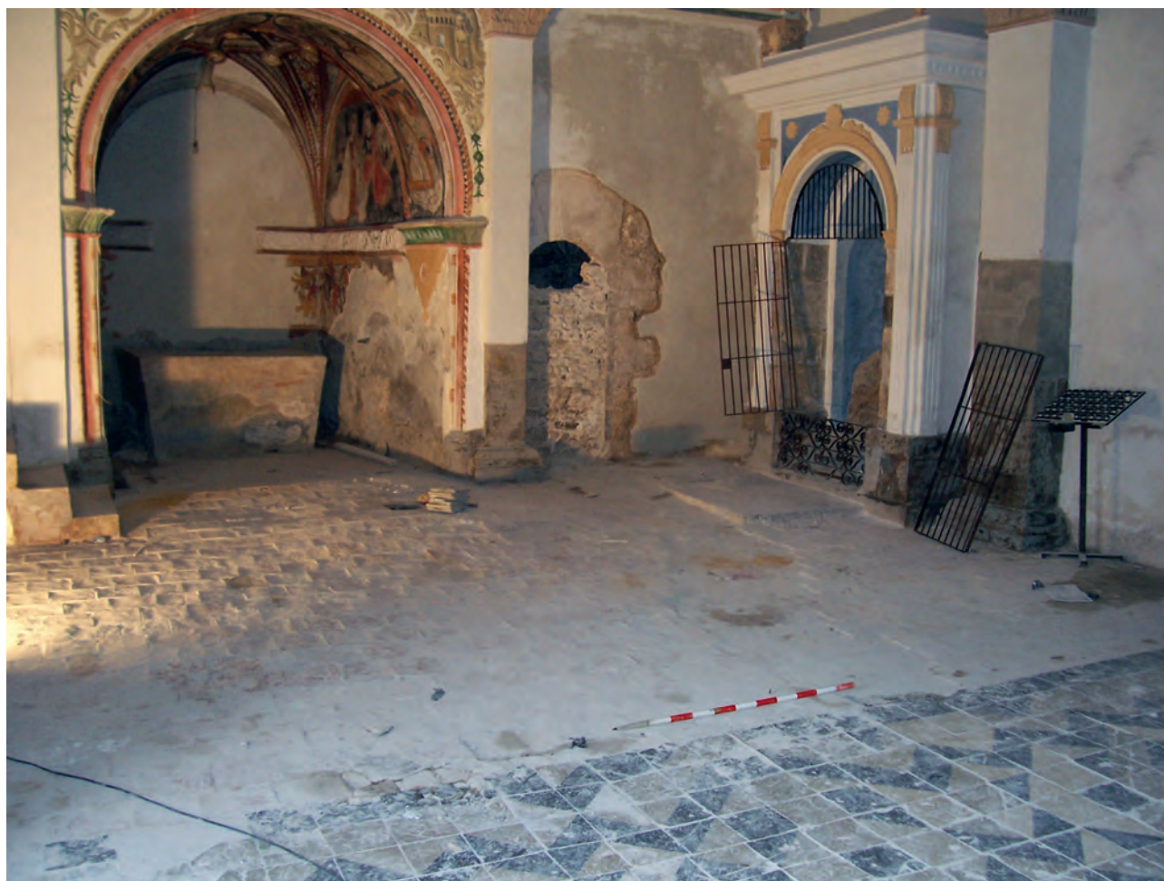
Figura 6. Vista interior de la nau abans d'excavar.
