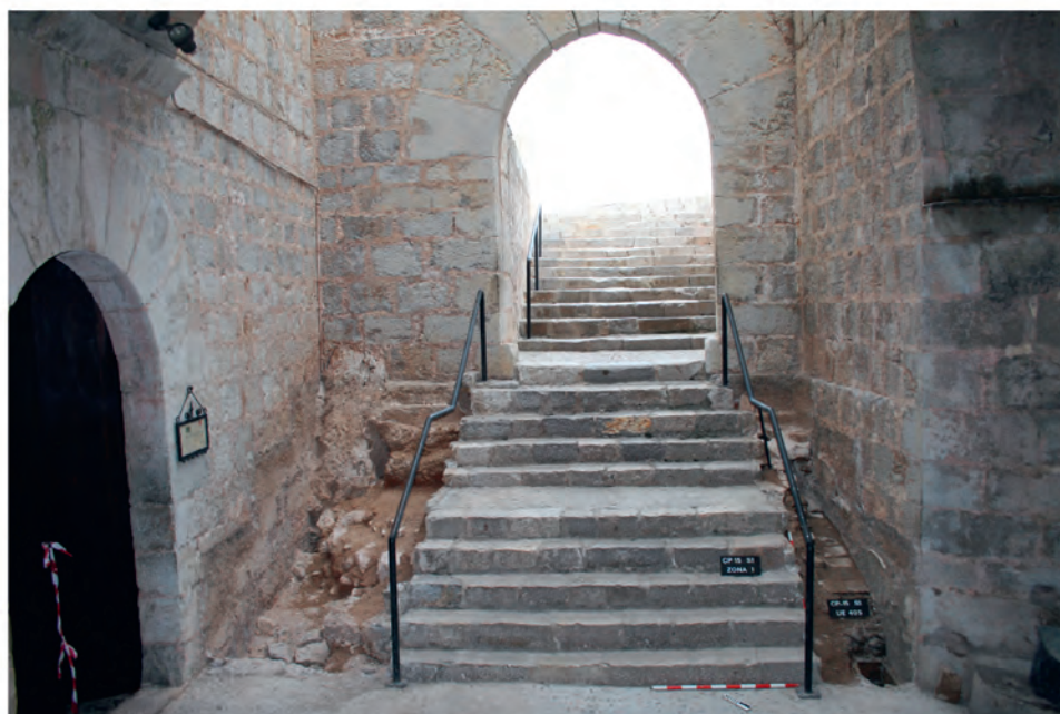
Figura 9. Estado final de las excavaciones en el tramo de acceso al Patio de Armas. Arriba a la izquierda se observa la cimentación y escaleras en piedra conservadas en la parte superior. En la imagen de la izquierda se observa la canalización y arqueta.
