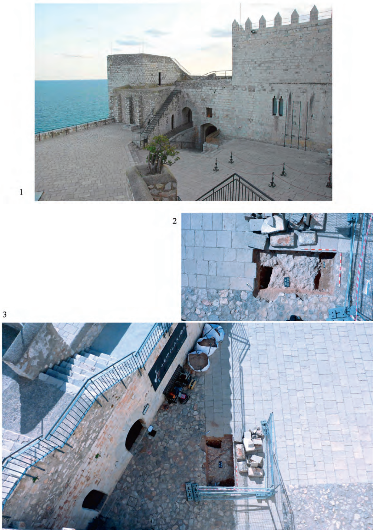
Fig. 16. 1. Vista de la situación de las dependencias del Papa Luna y acceso desde la Planta Baja. 2-3. Cimentación del claustro bajo-medieval.
