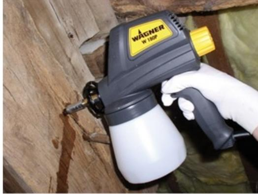
*Imagen 3.9: Inyección del tratamiento en la madera.*
