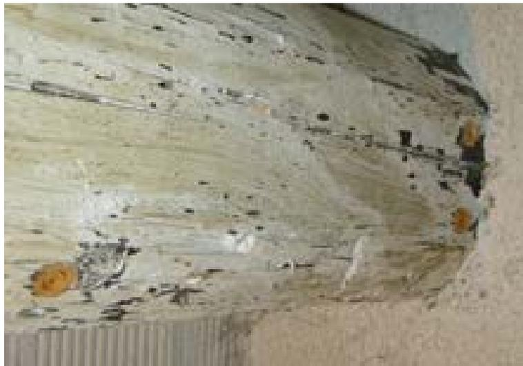
*Imagen 3.8: Vigueta con los inyectores colocados.*
