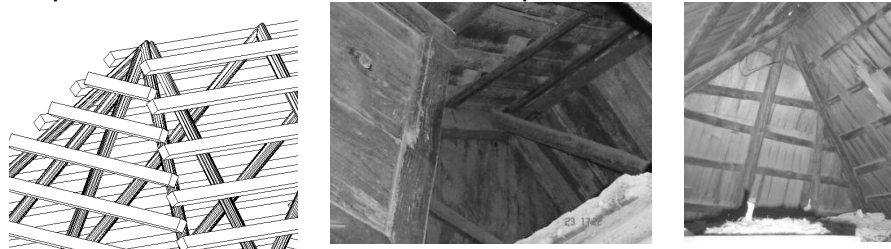
Figura 15. Estructura de madera en cubiertas de troje
