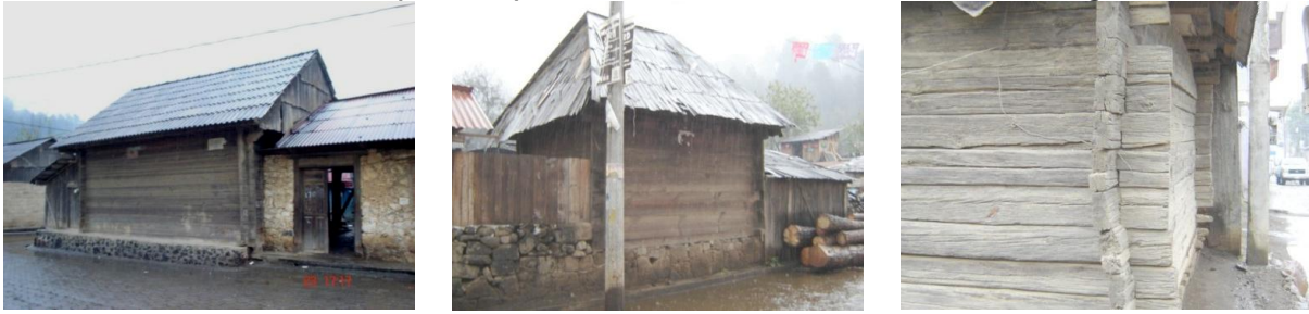
Figura 11. Elementos de madera ensamblados para la conformación de muros
