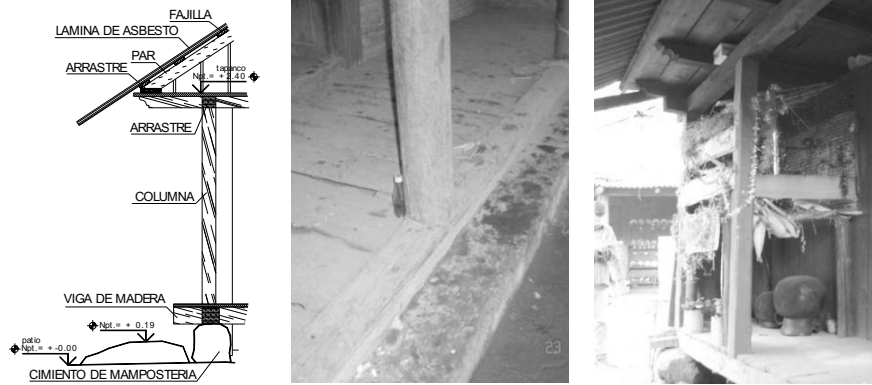
Figura 13. Columnas de pórticos en Trojes.
