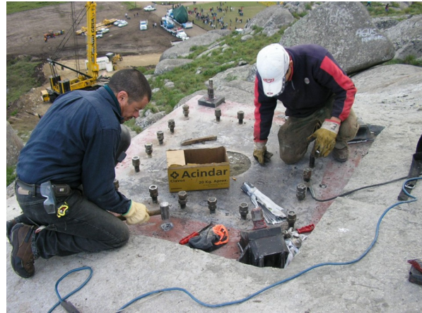
Figura 14. Placa de anclaje y bulones
