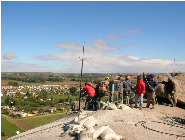
Figura 13. Perforaciones para los anclajes
