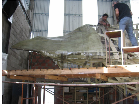
Figura 12. Construcción de la Cubierta
