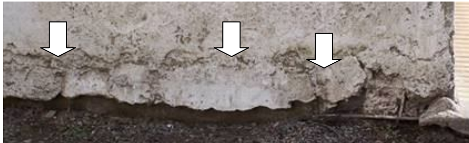
Figura 10. Defectos de llenado
