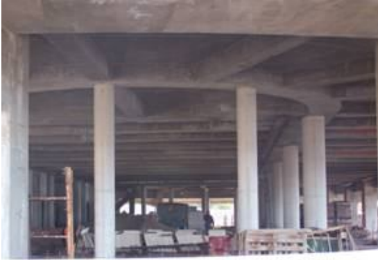
Figura 24. Vista nueva planta baja.
