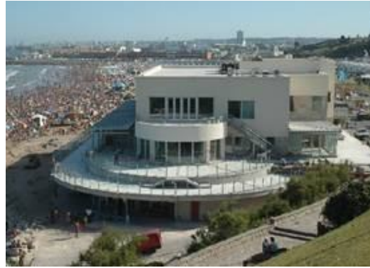
Figura 25. Vista norte del nuevo edificio.
