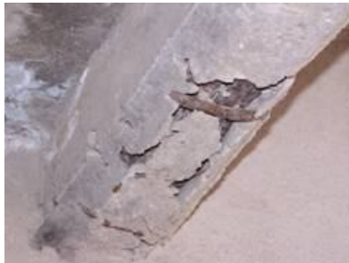
Figura 12. Defectos de llenado
