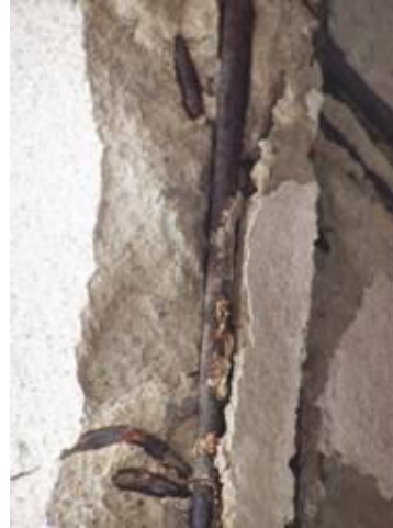
Figura 9. Recubrimiento insuficiente
