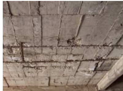
Figura 13. Recubrimiento insuficiente
