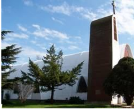
Figura 4. Vista sur de Iglesia
