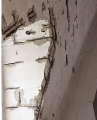
Figura 8. Armaduras expuestas
