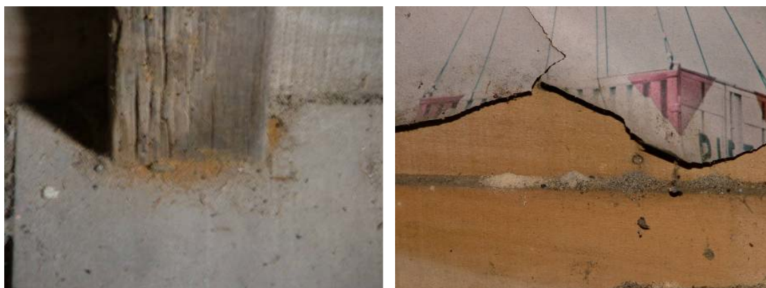
Figura 26 - Madera afectada por carcoma, en el taller del poeta-pintor A. Bustillo, en Berazategui.
