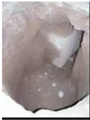
Figura 8: Exploración de fundación superficial
