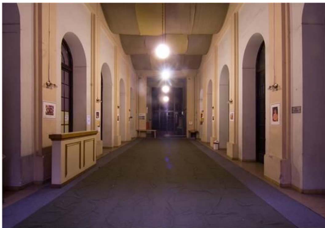
Figura 2: Pasillo de acceso a salas de teatro con cielorraso suspendido
