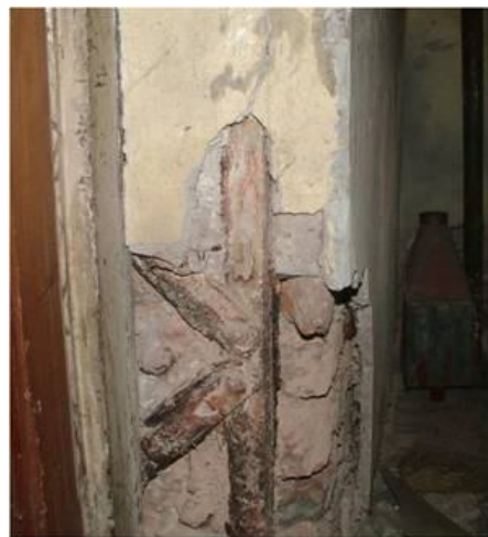
Figura 4: Estructura metálica de enmarcado de mampostería
