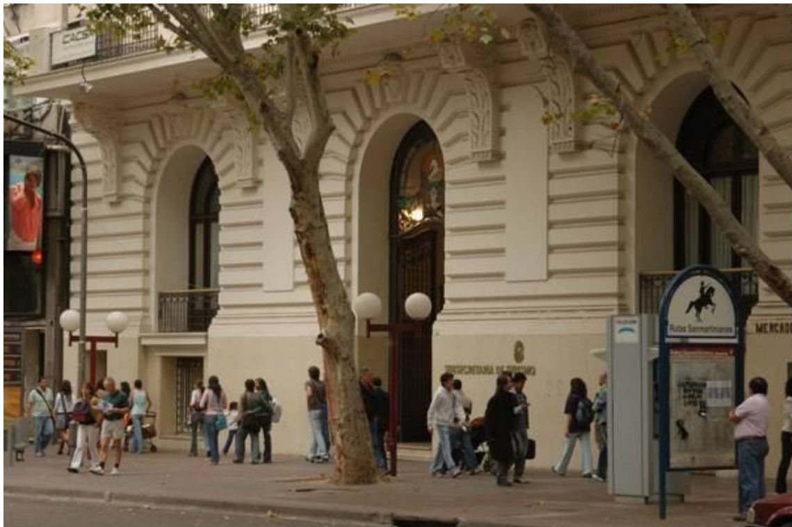
Figura 1: Fachada del edificio
