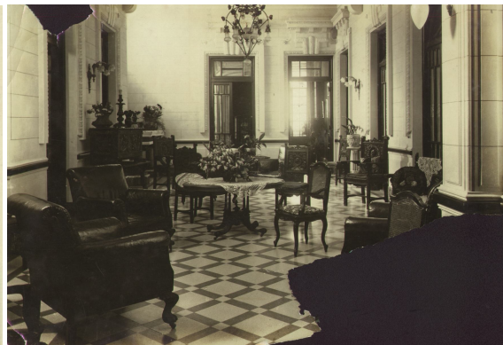
4 - Salón principal luego de la modificación de 1928 (antes patio)
