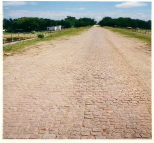
Fig. 4. Detalle de calzada mostrando el revestimiento de rocas graníticas.
