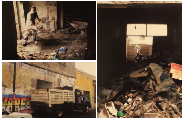
Figura 7: Retiro de escombros
