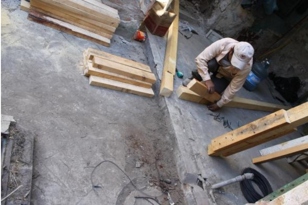
Figura 8: Trabajo de la madera para cimbra
