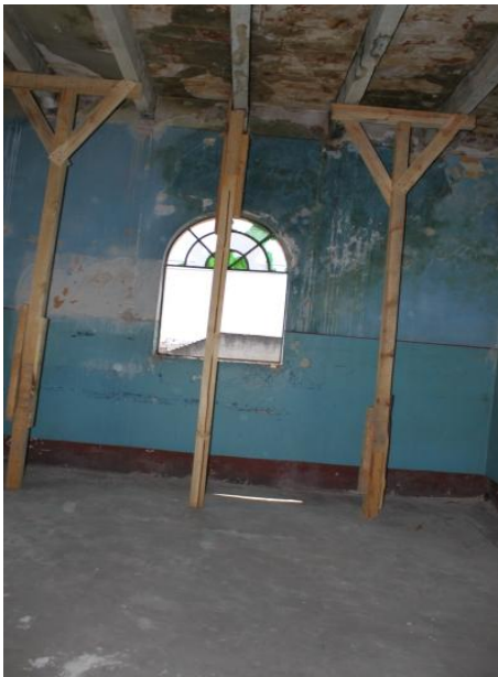
Figura 9: Apuntalamiento de losas
