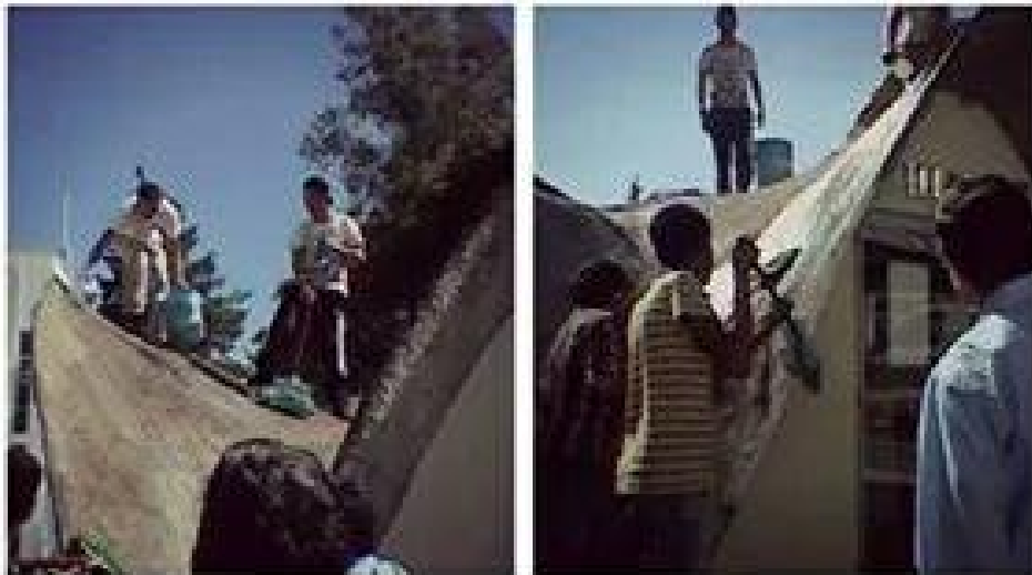
Figura 20: Trabajo de impermeabilización con alumbre y jabón
