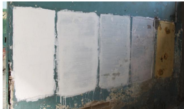
Figura 15: Muestras de pintura a la cal
