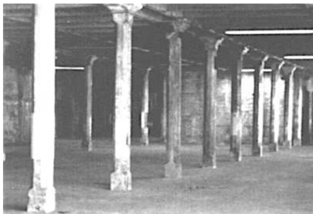
Figura 2. Estructura en hormigón armado siguiendo lineamientos de la construcción en perfilería metálica. Pacific Coast Borax Company, Alameda, California, 1893.
