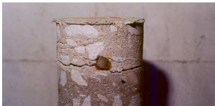
Figura 15. Fisuración por corrosión por carbonatación en hormigón de baja resistencia.
