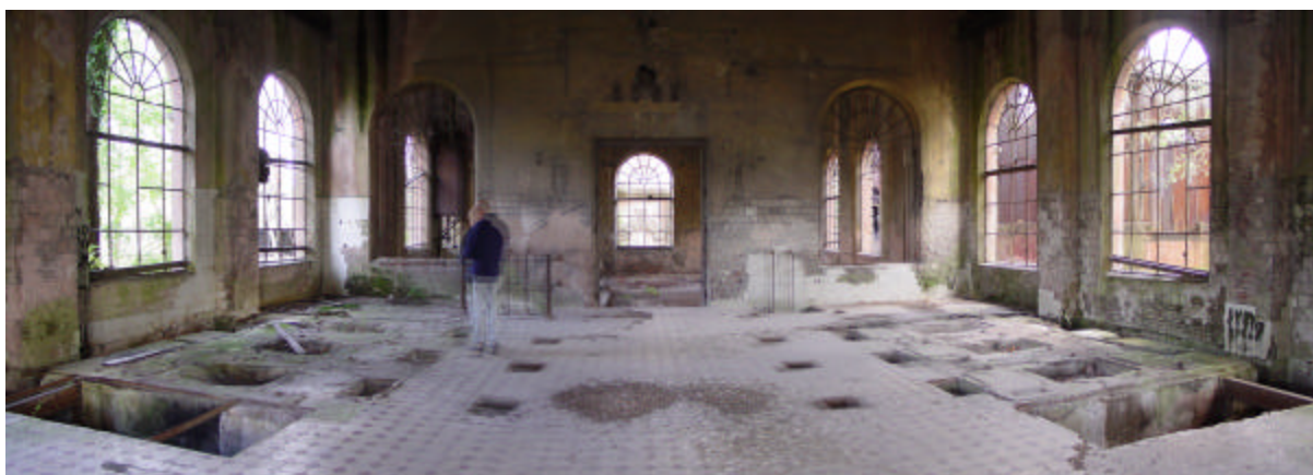
Fig. 8. Interior de la Sala de Máquinas.
