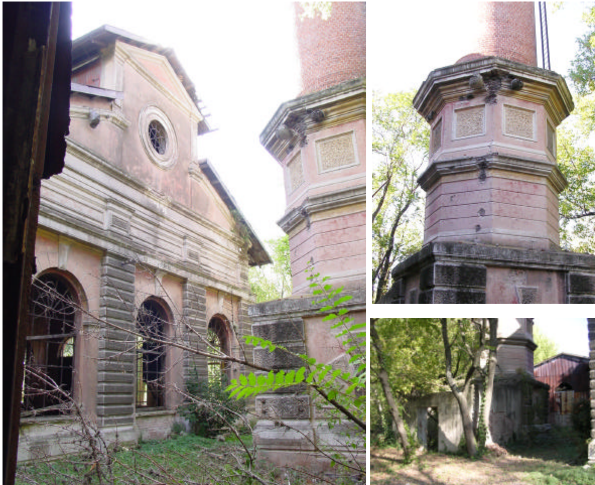
Fig. 4. Chimenea de la Estación Central y construcciones anexas.
