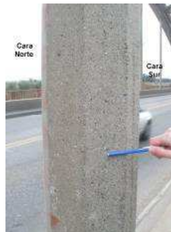
Imagen 17. Lavado del Hº de recubrimiento.
