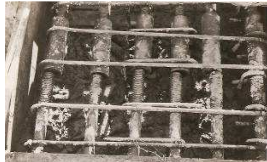
Imagen 8. Empalme de barras mediante "manguitos" en el tramo medio del arco.
