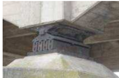
Imagen 10. Apoyo móvil de los arcos.
