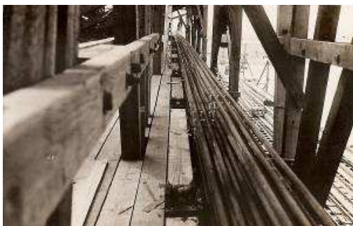
Imagen 7. Ubicación de barras de 50 mm de diámetro correspondiente a la cadena.
