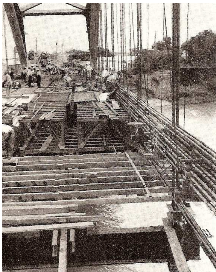
Imagen 11. Encofrado del tablero suspendido en péndolas.
