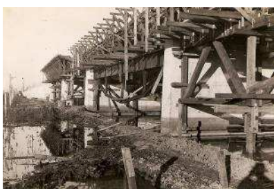
Imagen 2. Encofrado de los tramos principales de las vigas Gerber.
