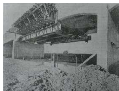
Imagen 3. Encofrado colgado de los tramos suspendidos de vigas Gerber.
