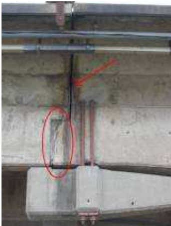
Imagen 32. Anclaje suplementario por rotura en apoyo fijo de viga Gerber.
