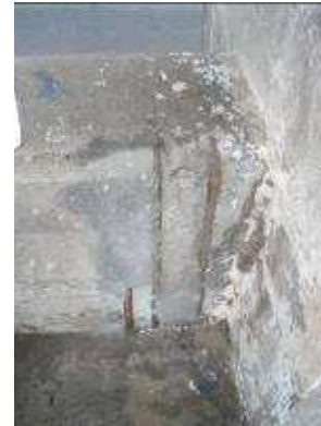
Imagen 25. Cadena, encuentro con arranque del arco.
