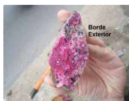
Imagen 14. Determinación de carbonatación en hormigón de recubrimiento retirado.
