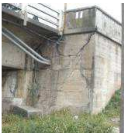
Imagen 34. Estribo: margen "santotomesina". Imagen 35. Refuerzo en la margen "santotomesina".
