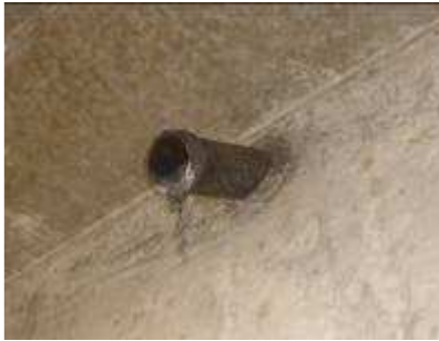
Imagen 29. Prolongación del caño de desagüe pluvial.
