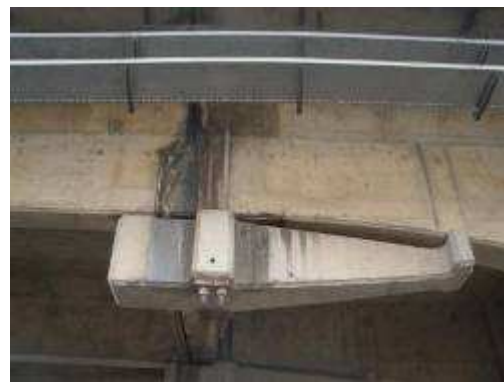
Imagen 32. Anclaje suplementario por rotura en apoyo fijo de viga Gerber.
