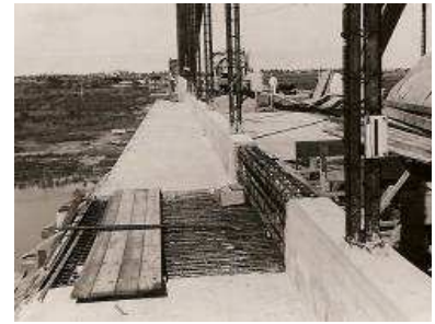
Imagen 6. Tramo central sin hormigonar para evitar la contracción por fragüe.
