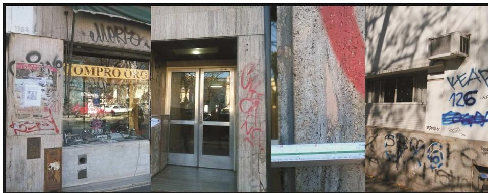
Figura 1: Fachadas revestidas con placas de travertino relevadas.
