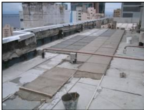
Fotografia 20. Proteção térmica e proteção mecânica sobre a impermeabilização.
