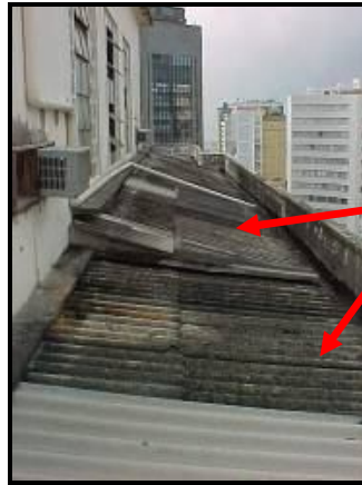
Fotografia 10. Falhas nas fixações e vedações do telhado.
