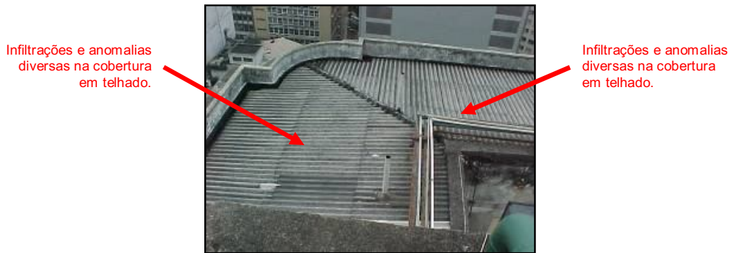
Fotografia 7. Vista do nível cobertura em telhado desde laje mais superior.
