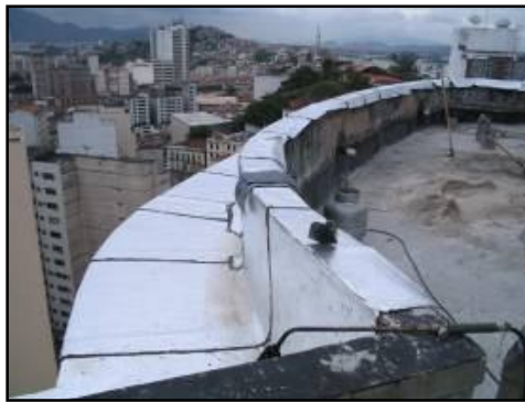
Fotografia 19. Impermeabilização da laje de beiral com manta asfáltica autoprotégida.
