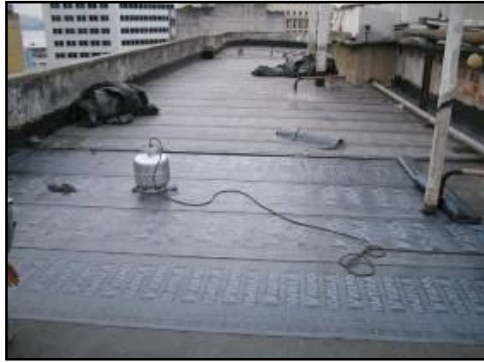
Fotografia 16. Impermeabilização com mantas asfálticas em camada dupla.
