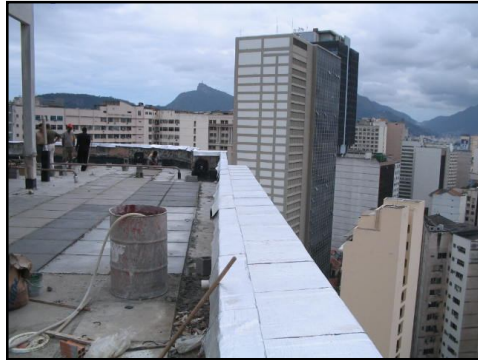
Fotografia 21. Impermeabilização da laje de cobertura, muretas e lajes de beirais.
