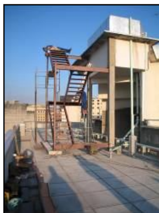
Fotografia 23. Montagem de escada sobre a impermeabilização concluída, para acesso à cobertura mais superior.
