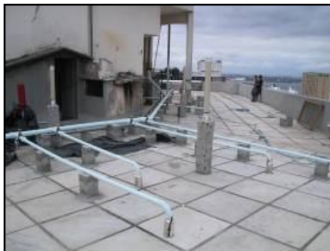
Fotografia 22. Impermeabilização concluída e aspecto das instalações hidráulicas.
