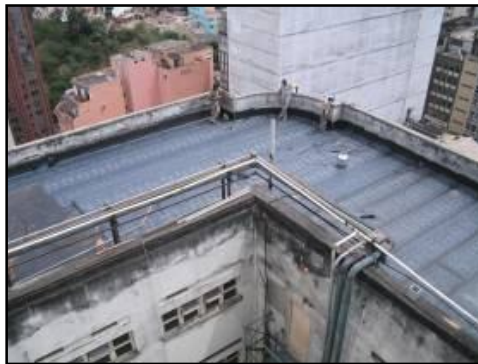
Fotografia 17. Vista da impermeabilização durante aplicação.
