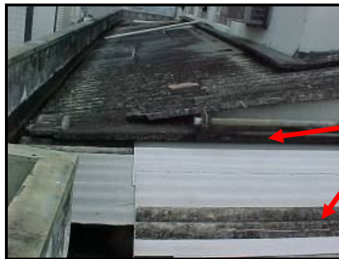
Fotografia 11. Telhas quebradas e infiltrações através do telhado.
