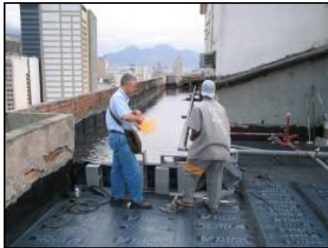
Fotografia 18. Verificação do ensaio hidráulico sobre a impermeabilização realizada.
