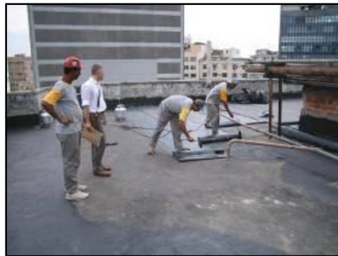
Fotografia 14. Impermeabilização na laje de cobertura após remoção do telhado.
