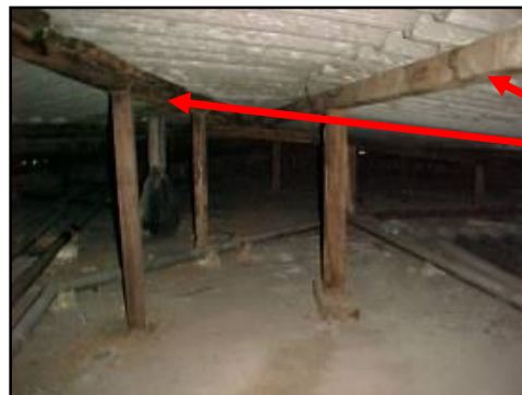
Fotografia 12. Infiltrações em incidência na madeira de suporte do telhado.
