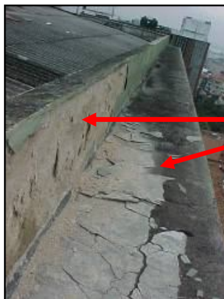
Fotografia 6. Deslocamento e infiltrações nas platibandas e lajes de beirais.
