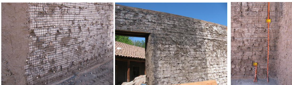
Figura 7 – Refuerzo con geomalla en recuperación de monumentos [5]
