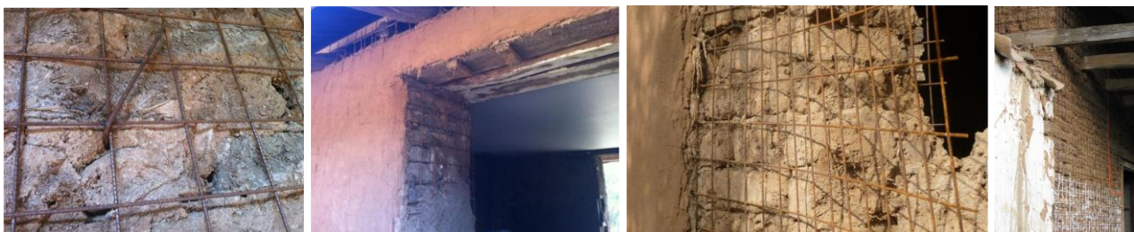
Figura 6- Aplicación de malla electrosoldada en recuperación de viviendas [6]
