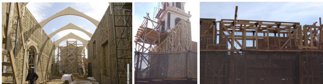
Figura 3- Entramado de madera en Iglesia Santa Inés de La Serena [7]
