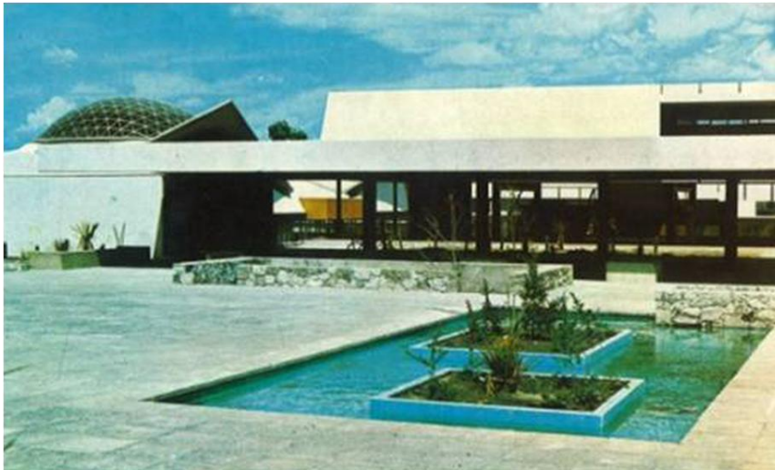
Figura 1. Vista de la Facultad de Arquitectura, Benemérita Universidad Autónoma de Puebla, México
