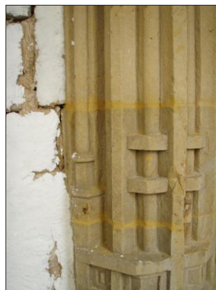
Figura 2 – Aplicación de apósitos absorbentes de celulosa para eliminación de sales
