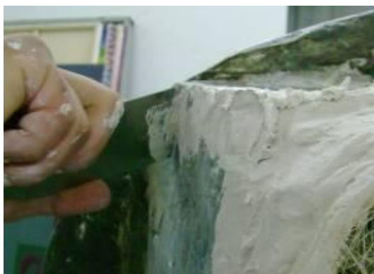
Figura 22. Nivelación de los rellenos
