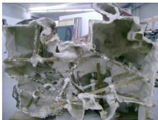
Figura 14. Interior de la escultura antes del refuerzo estructural
