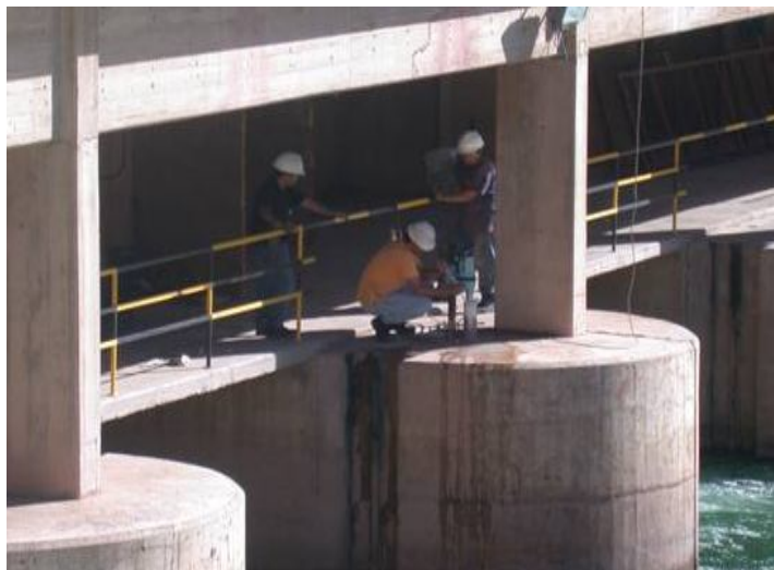
Figura 4. Pilares de Dique El Nihüil - Mendoza
