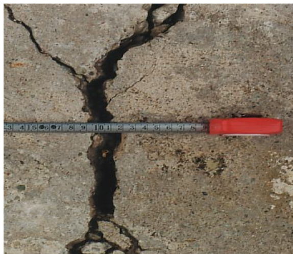
Figura 3. Hormigón de la presa "El Cadillal" Tucumán.
