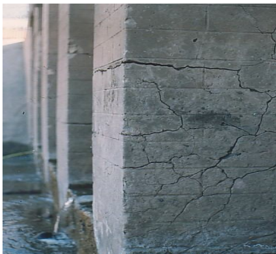
Figura 2. Pilares de compuerta reguladora de agua. Cinco Saltos. R. Negro
