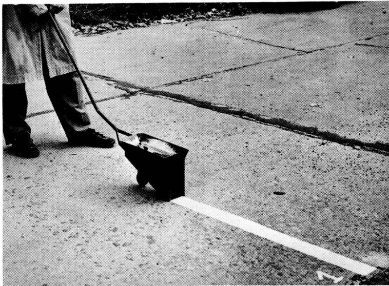
Fig. 2.- Aplicación sobre pavimento para ensayo en servicio
