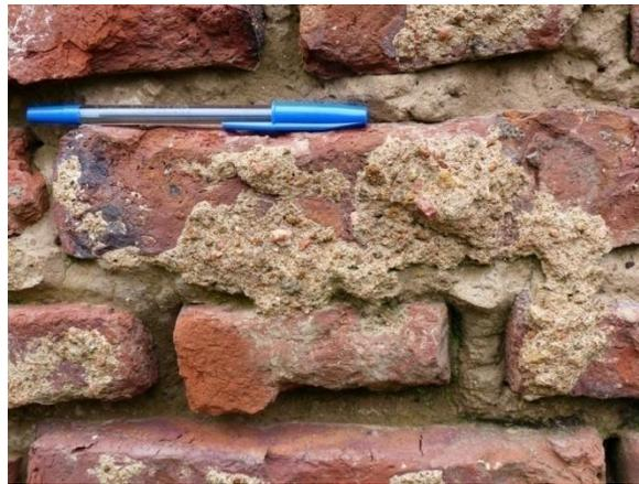
Figs. 5 (izquierda) y 6 (derecha). Sector de la pared posterior con ladrillos al descubierto. Se alcanza a distinguir la junta y dos revocos de diferente tonalidad, uno interno (amarillento castaño pálido) y otro más externo (gris blanquecino). En ambos revocos se distinguen fragmentos de trituración (mayormente rocas de composición granítica) y escasos fragmentos de ladrillo.
