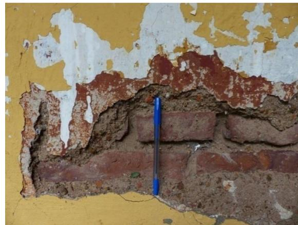
Figs. 7 y 8. Izquierda: detalle de la moldura de ventana (alféizar) con desprendimiento del revoque. Derecha: vista de una pared interior del Almacén, con revoque grueso recubierto por otro fino de espesor milimétrico y, al menos, cuatro capas de pintura (rojo pálido, rojo más oscuro, blanco y amarillo). Los fragmentos de ladrillo son comunes en el revoque grueso y pueden observarse en ambas figs.
