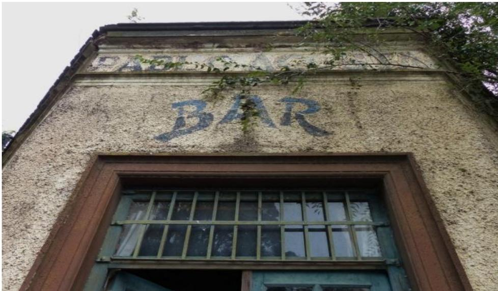
Fig. 4. Vista del frente de la construcción. Se observa la presencia de un revoque salpicado.
