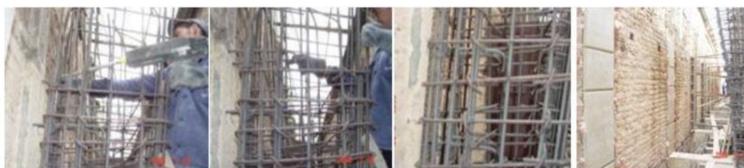
img. 22 Detalle del proceso de anclajes de la nueva estructura a las columnas y muros existentes. Se utilizó un anclaje en acero cada 25 cm con una profundidad de 15 cm y epóxico ref. Simpson.
