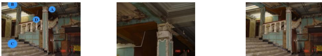
img. 5 Los diferentes tipos de columnas y vigas en la zona del vestíbulo o foyer, en concreto reforzado 30*30 cm. Definición de las escaleras (C, D) en concreto reforzado y recubrimientos en granito fundido y pulido.
