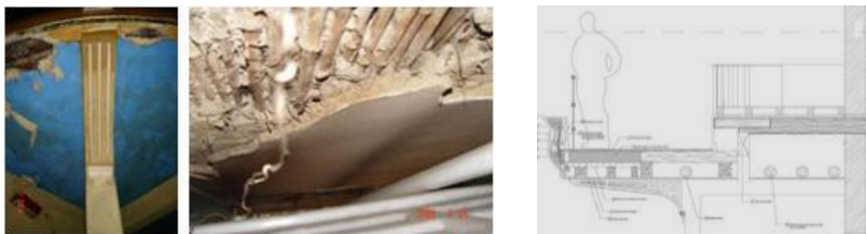
img. 13 Detalle de los cielorasos en bajo palcos y vestíbulo, imágenes 2005 y detalle de propuesta niveles de proyecto de refuncionalización.
