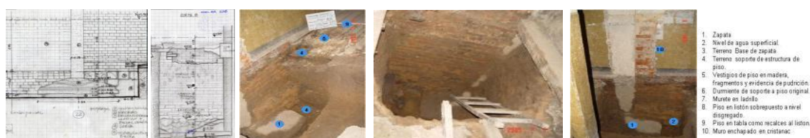
img. 2 Detalle de la exploración No 1 eje B-7, en la cual se puede apreciar el nivel de la zapata, la presencia de agua libre y la disposición del muro en mampostería. Exploración No 5 eje A.22.
