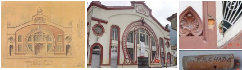
img. 9 . Detalle la fachada según el anteproyecto de 1922, la fachada en el año 2004, algunas exploraciones de los muros en zócalo y detalle corte fachada por acceso.
