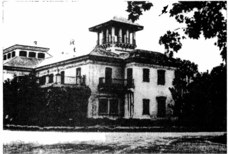
Aquí se destaca, en primer lugar, la casa principal, un edificio de dos plantas, con amplia galería, azotea y mirador, característico de la arquitectura rural. Su lenguaje arquitectónico corresponde a la corriente neocolonial, movimiento que, a partir de la segunda década del siglo, planteó la reinterpretación de formas provenientes del pasado hispánico como reacción frente al eclecticismo internacionalista vigente en la época.
