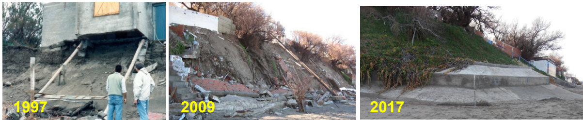
Figura 6. Deterioros producidos por la tormenta de 1997, 2009 y 2017 en la zona de Villa Faro Recalada en Monte Hermoso.
