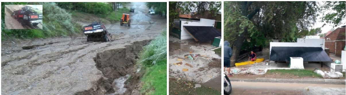
Figuras 7. Inundaciones y socavaciones en las calles sin asfalto
