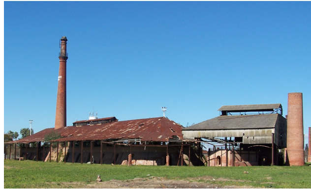
Horno de ladrillos desactivado, CTIBOR. Año 2006
