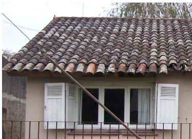
Cubierta de una vivienda del Barrio Obrero (Berisso)
