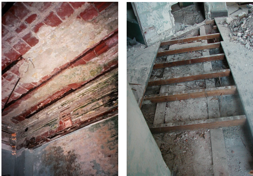
Figura 7 – Entrepiso del Hotel Colón: Cara inferior y superior descubriendo las bovedillas sobre las que se dispone el entramado de madera y entablonado que oficia de pavimento.
