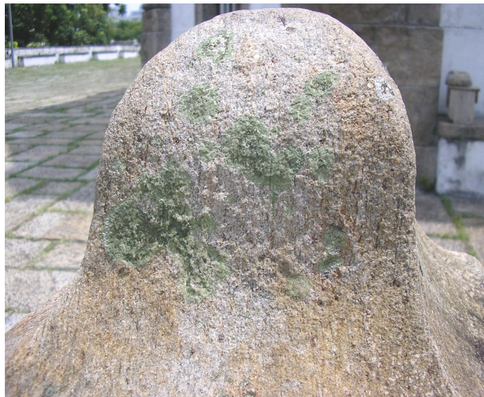
Foto 16 - Após a remoção da pasta de argila, obteve-se uma limpeza parcial
