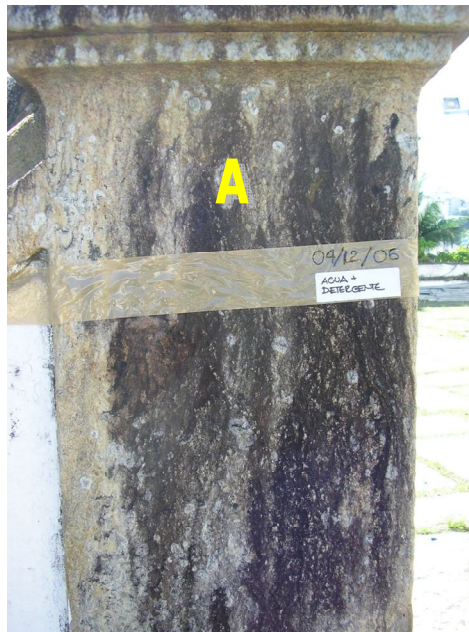
Foto 10 - Vista da pilastra do adro antes da limpeza
