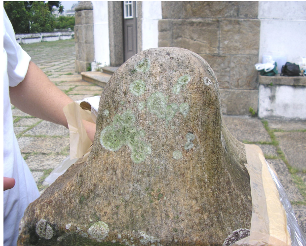
Foto 15 - Presença dos líquens, mesmo após a aplicação da polpa de algodão com formaldeído
