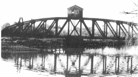
Figura 9: Puente ferroviario giratorio
