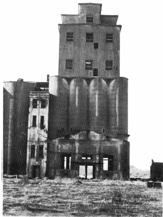
Figura 3: Silos de granos
