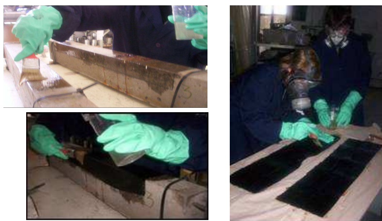
Figura 11. Técnica de refuerzo y/o reparación con polímeros reforzados con fibras de carbono.
