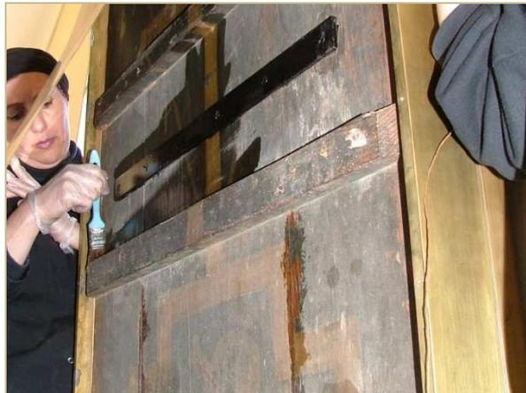
Fig 14 y 15 Limpieza y posterior impregnación de biocida
