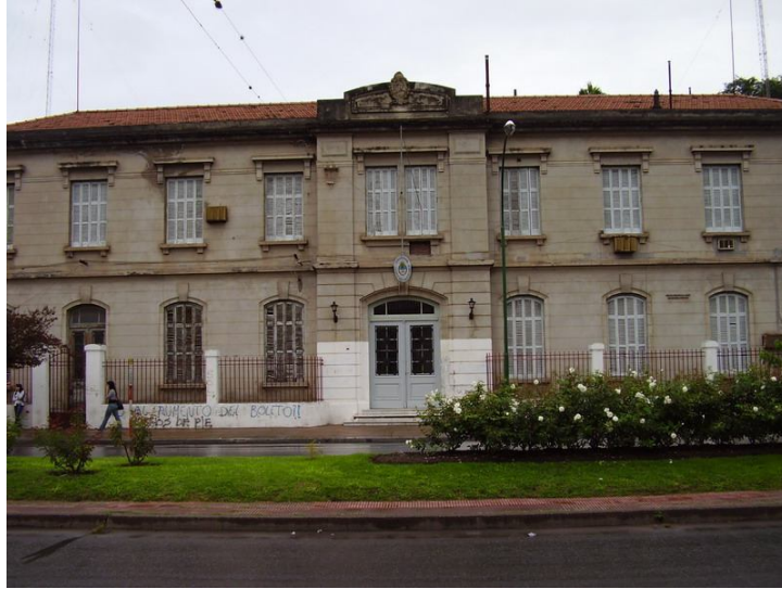
Figura 2: Fachada del pabellón principal.
