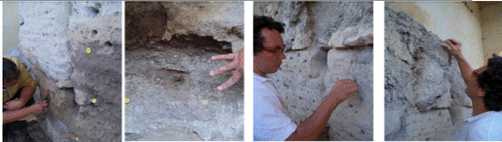
Figura 6. Segmentos de prueba con dispositivo de penetración y de muestreo para evaluación de propiedades físico-mecánicas y análisis mineralógico de la tapia pisada del Paredón de los Mártires.
