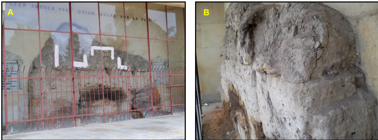
Figura 1. (A) Vista general del Paredón de los Mártires. (B) Detalles de su morfología irregular por desgaste, erosión y humedad.
