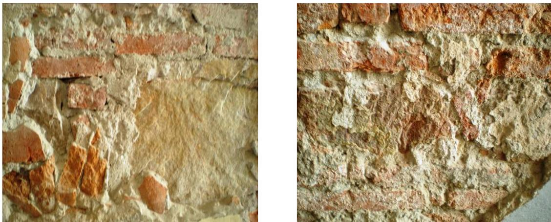
Figura 8: Observación de un sector del muro descarnado de la iglesia La Viña
