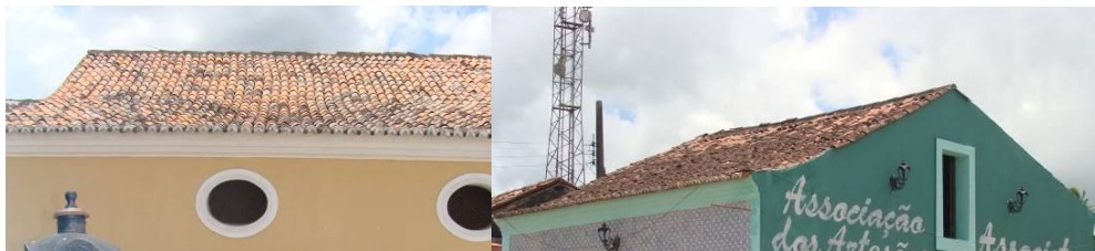
Figuras 20 e 21: Cobertas em 2 águas e telha colonial; Fonte: Daniella Esposito, 2009
