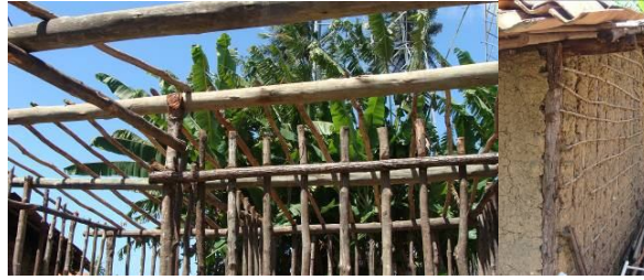
Figuras 16 e 17: Técnica construtiva do tipo Taipa de Mão ou Sopapo; Fonte: Daniella Esposito, 2009
